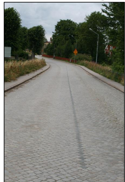
Vägbeläggningen på den nord-sydliga vägen.
