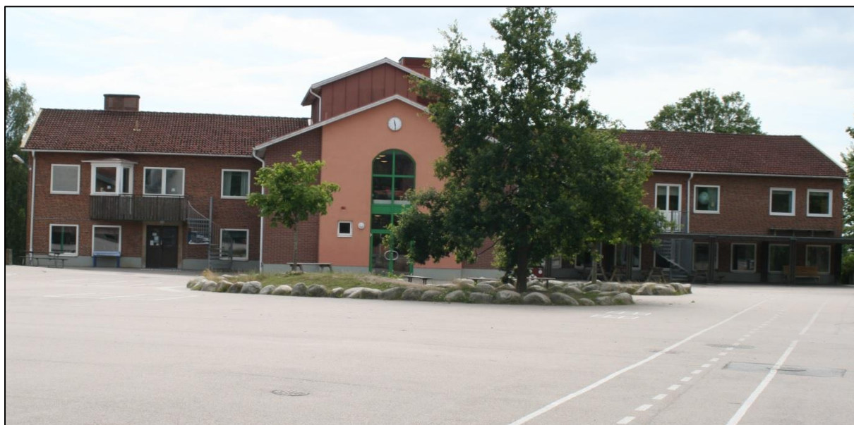
Den större av 1956 års skolbyggnader. Fasad mot skolgården.
