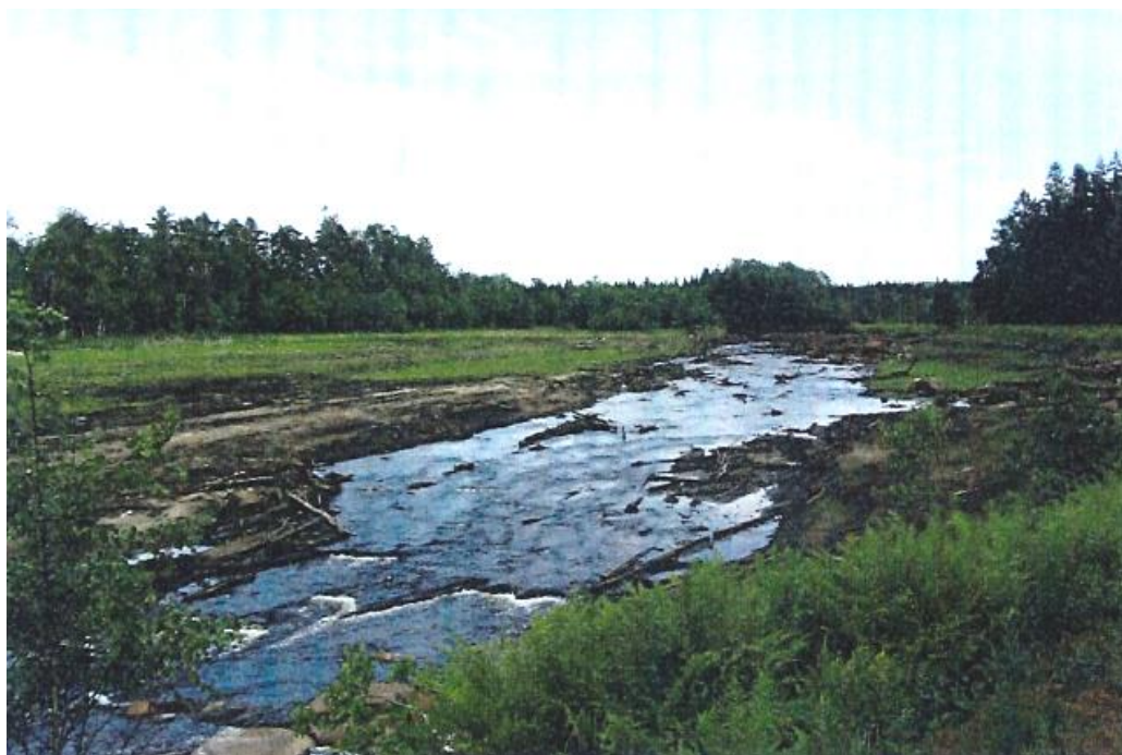
Figur 2. Utrivning av damm i Halland 2022, ur tekniska beskrivningen. Enligt sökande avsåg man att sänka dammen i samband med utrivning i maj och fotot är taget i juni samma år.
