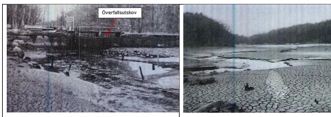
Figur 1. Bilder från tidigare avsänkning av Hammarmölledammen, uppvisade vid huvudförhandlingen. Enligt sökande kan en avsänkning av denna omfattning ske genom öppnande av bottenluckan, dvs utan eller innan att utrivning sker.
