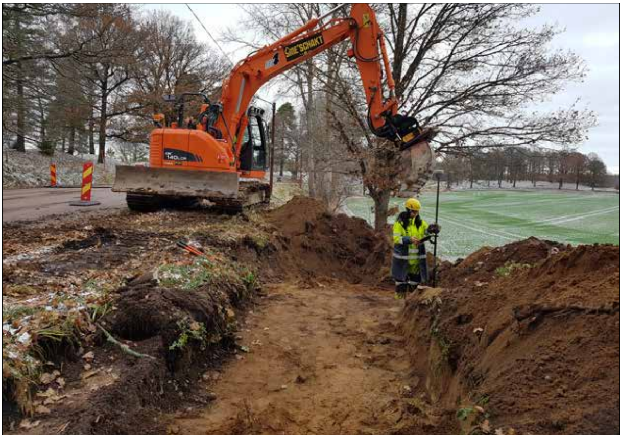
Figur 12. Söschaktning inom yta 4. Foto Ann Vinberg från söder.
