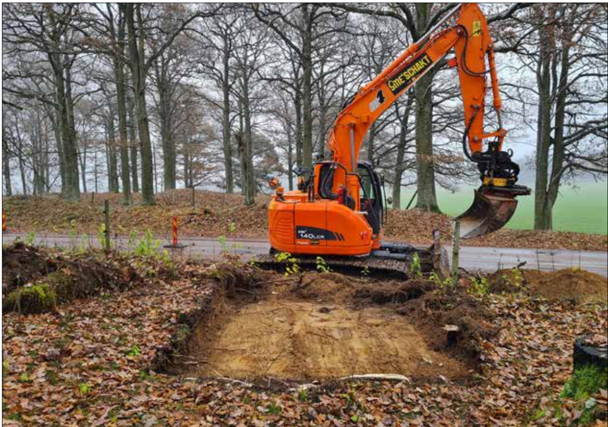
Figur 27. Schakt 1181 inom yta 2. Foto från norr.
