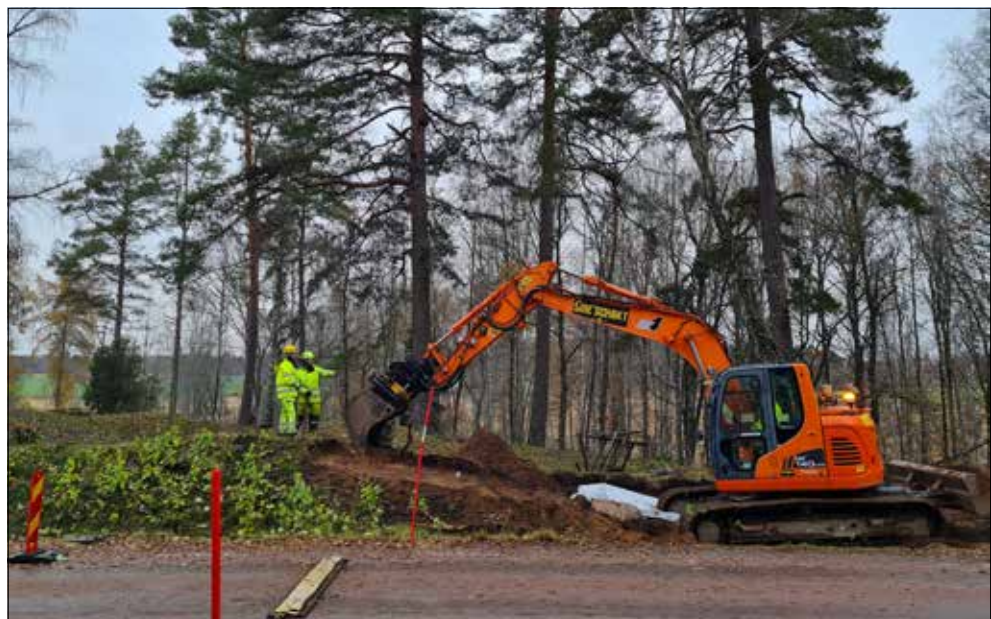
Figur 19. Grav 4 under undersökning. Ann Vinberg och Kerstin Odebäck vid grävmaskinen. Foto från sydöst.
