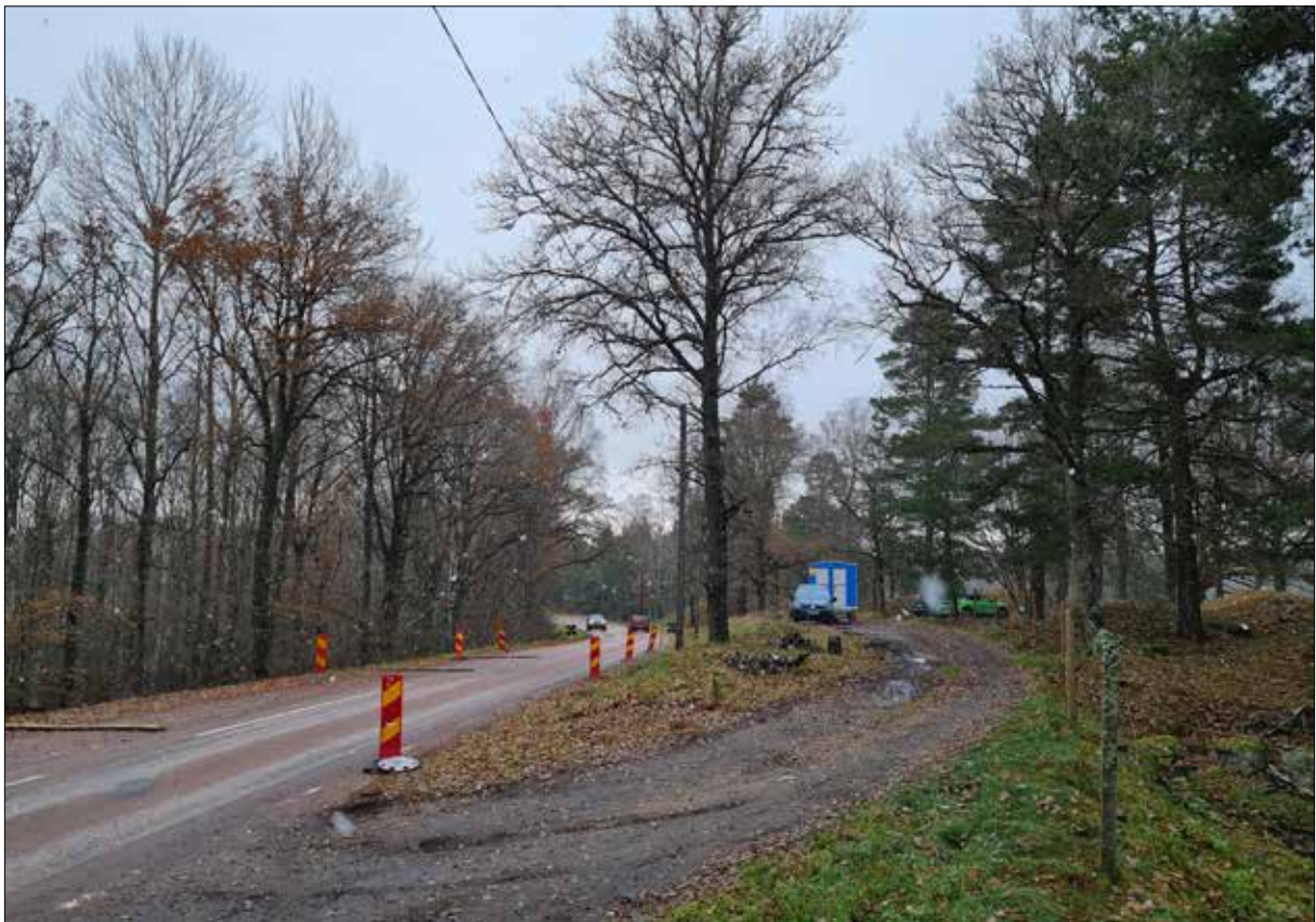
Figur 9. Gamla och nya vägen i november 2023. Foto från söder.
