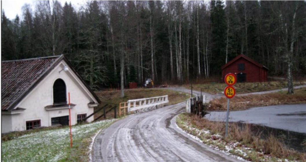
Figur 12. Dohnafors kvarn, dammbyggnad och del av dammspegel. Järnboden skymtar i bakgrunden.
