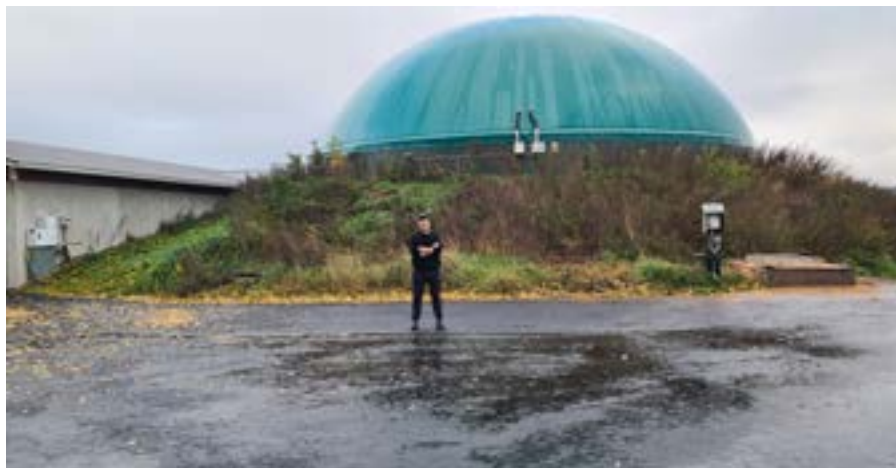
Nedgrävd biogasanläggning för ökad isolering.
