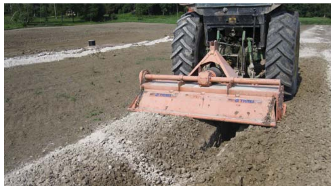
Bild 8. Strukturalken sprids jämnt över täckdikets jordsträngar. Foto: Åsa Kuhlau. Bild 9. Inblandning med jordfräs innan diket återfylls. Foto: Björn Lagerdahl.
