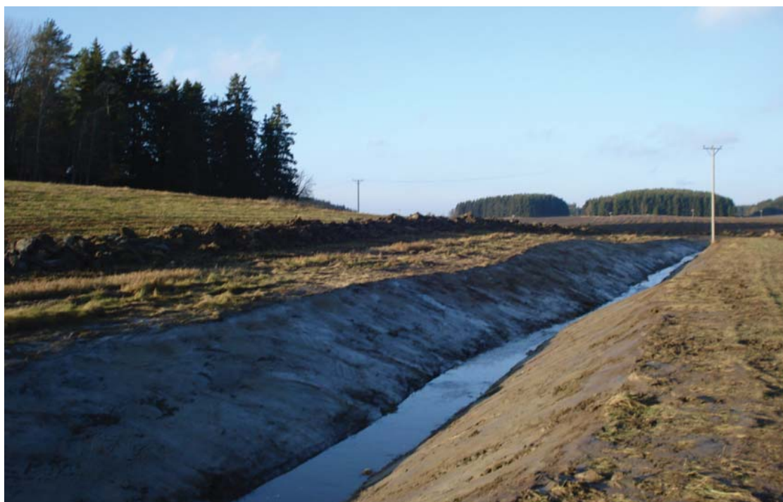
Bild 12. Samma dikessträcka efter avfasning av slänter. Foto: Lars Juhlin
