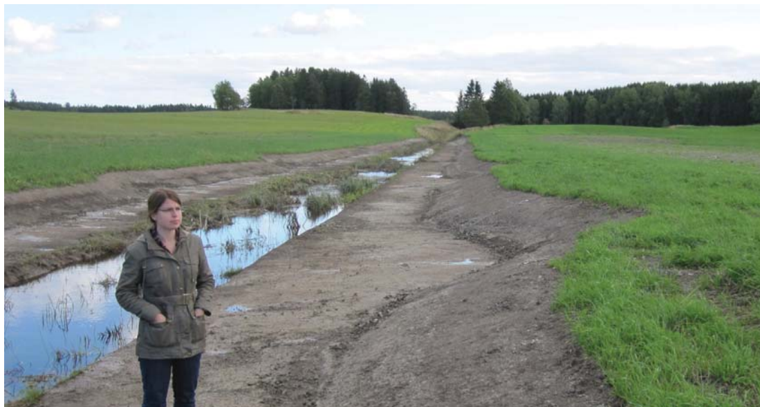
Bild 13. Exempel på utformning av ett tvåstegsdike. Foto: Lars Juhlin
