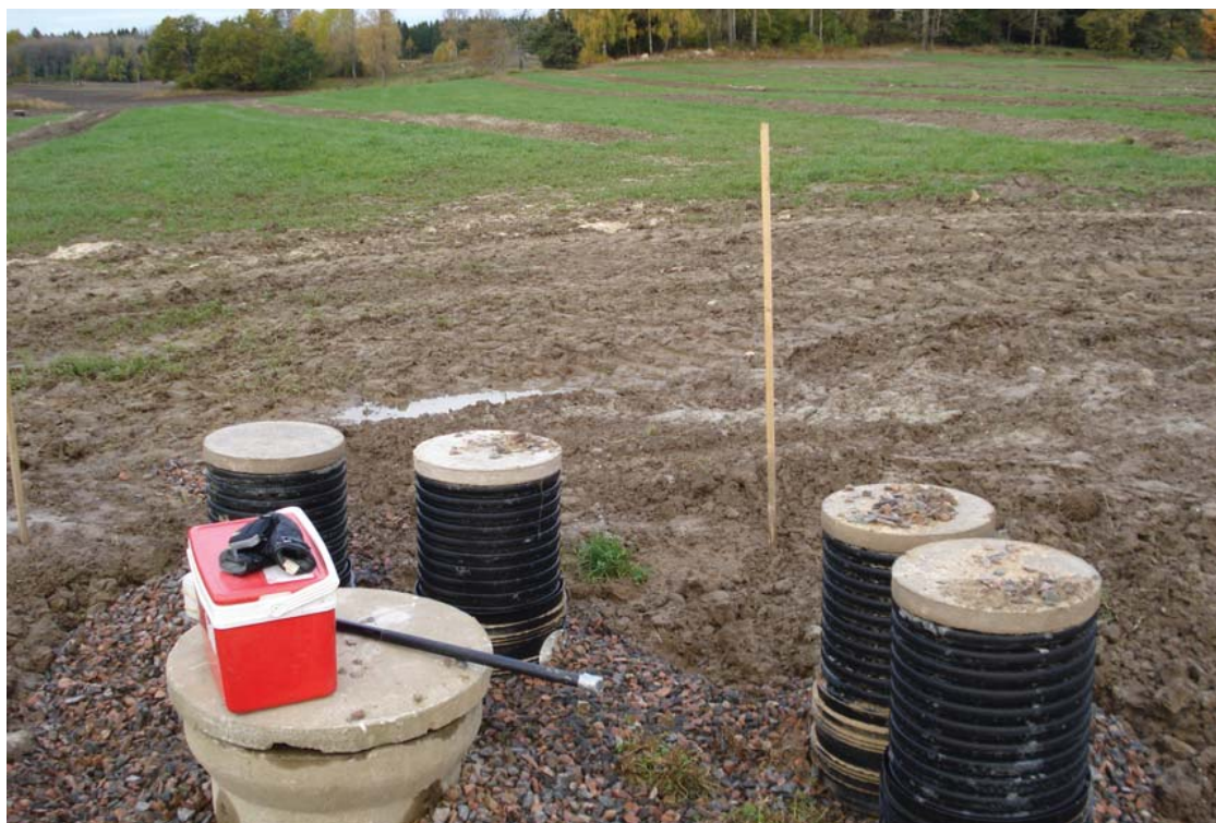
Bild 29. Provtagningsbrunnar för kalkfilterdiken vid Öknaskolan. Foto: Åsa Kuhlau.
