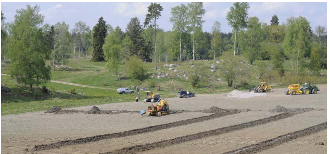
Bild 18. Anläggning av kalkfilterdiken på Öknaskolan 2011. Foto: Björn Lagerdahl
