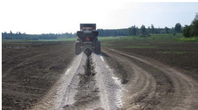
Bild 8. Strukturalken sprids jämnt över täckdikets jordsträngar. Foto: Åsa Kuhlau. Bild 9. Inblandning med jordfräs innan diket återfylls. Foto: Björn Lagerdahl.
