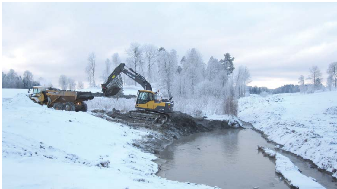
Bild 20. Grävning av fosfordamm 2012. Foto: Åsa Kuhlau
