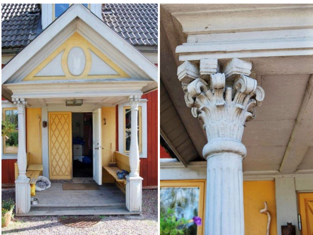
Figur 4-5. Förstukvisten är troligtvis original från 1748, och bärs upp av korintiska kolonner. Foto: Olle Lind, Länsstyrelsen i Dalarnas län.
