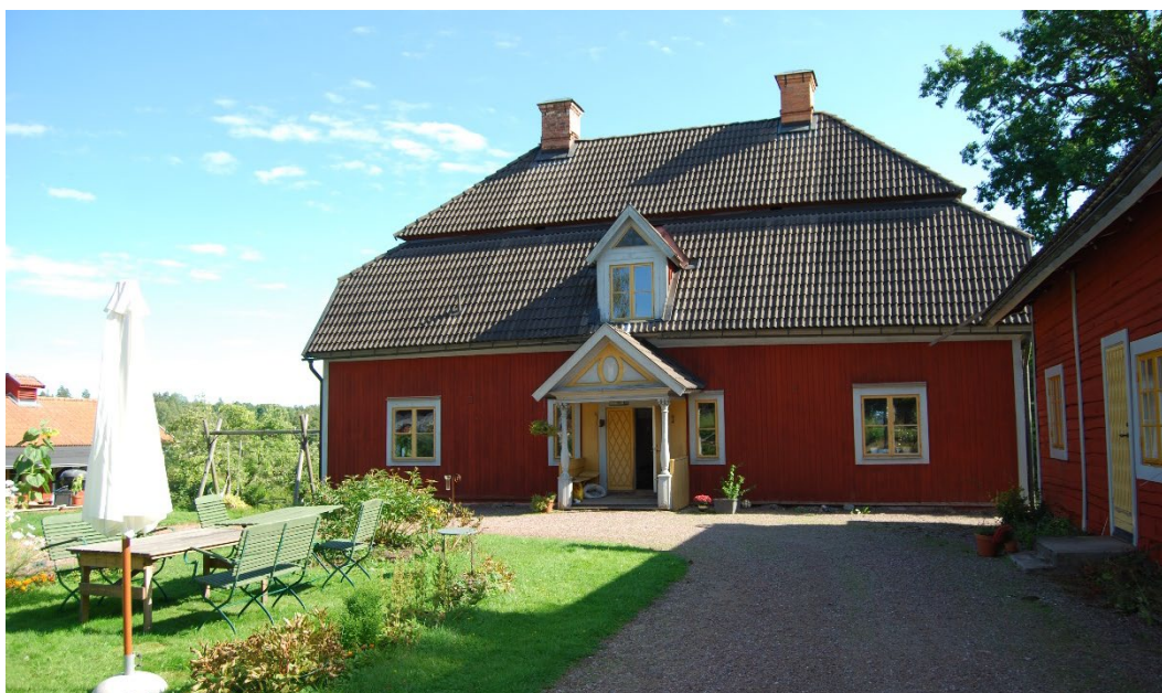
Figur 3. Huvudbyggnaden har ett för 1700-talet karaktäristiskt säteritak. Foto: Olle Lind, Länsstyrelsen i Dalarnas län.
