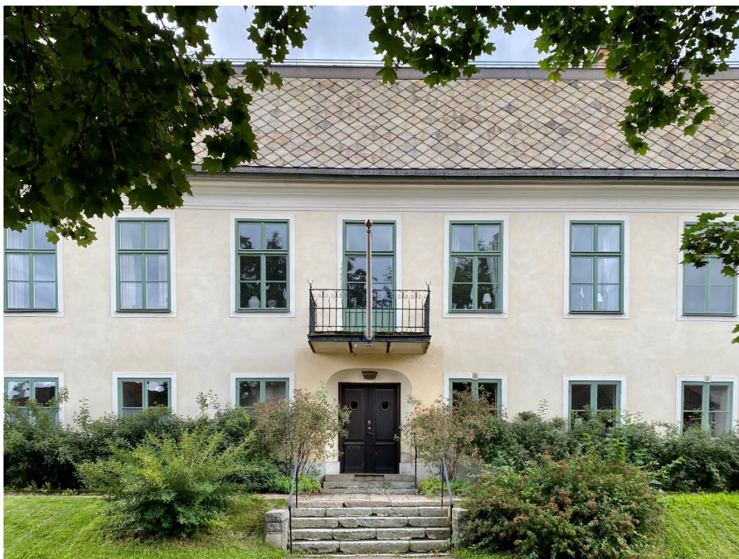
Figur 2. Fasaden mot innergården med huvudentrén centralt placerad i långsidan. Taket är belagt med skiffer från Glava. Foto: Lovisa Lindberg, Länsstyrelsen i Dalarnas län.
