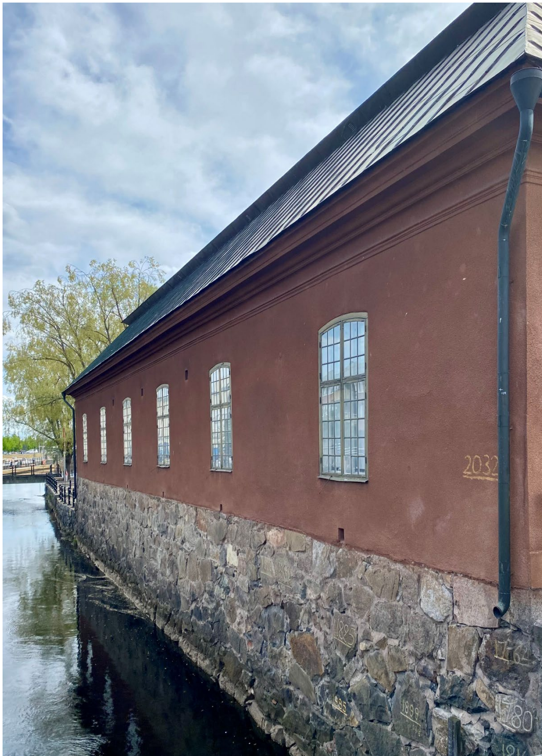
Figur 6. Grundmuren vilar direkt på åbotten. Längst till höger i bild syns årtal som markerar höga vattennivåer i ån genom historien. Foto: Lovisa Lindberg, Länsstyrelsen i Dalarnas län.
