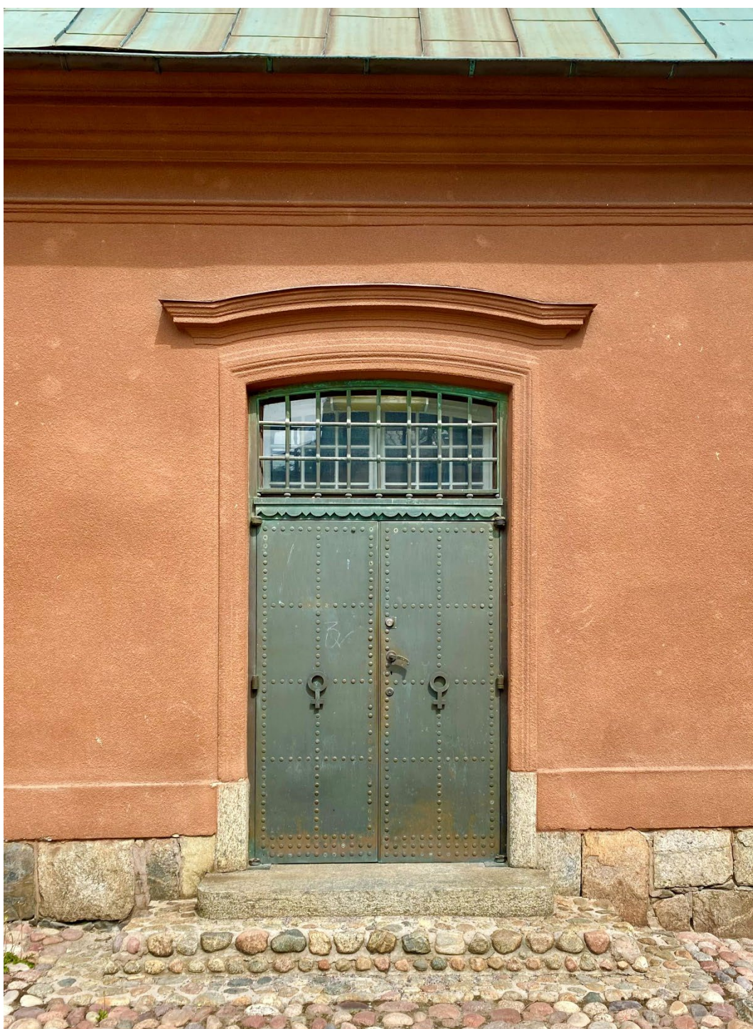
Figur 5. Kopparklädda pardörrar, ritade av Peder Clason 1926. Foto: Lovisa Lindberg, Länsstyrelsen i Dalarnas län.
