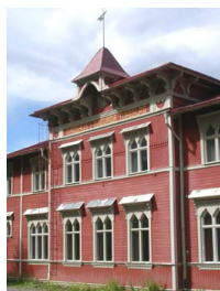
Sommarhagen på Frösön och tingshuset i Ragunda, två av Jämtlands byggnadsminnen. Foto: Länsstyrelsen i Jämtlands län
