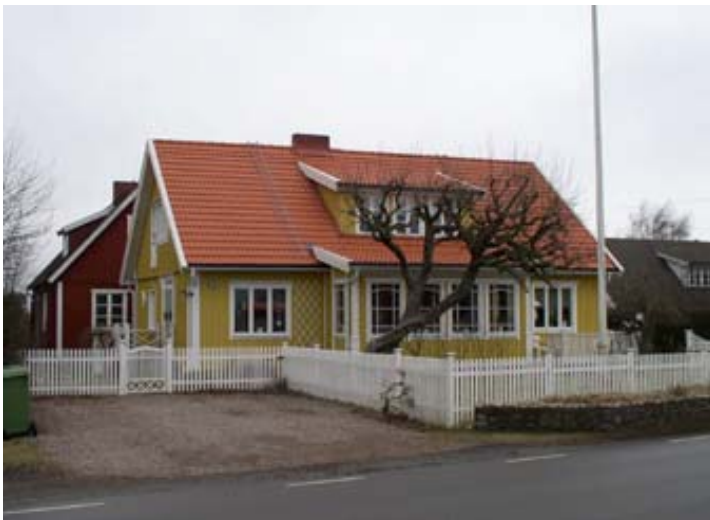
I denna fastighet drevs fram till 1970-talet Arvid Karlssons affär. Här har även funnits vagnmakeri. Byggnadernas kulturhistoriska värde har förvanskats genom senare tiders val av material och färgsättning.
