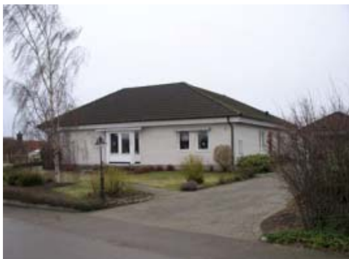
Enplanshus med valmat tak täckt med betongpannor. I princip kvadratisk grundplan. Den här typen av hus är inte på något sätt anpassad till karaktärsdragen i Magnarp.
