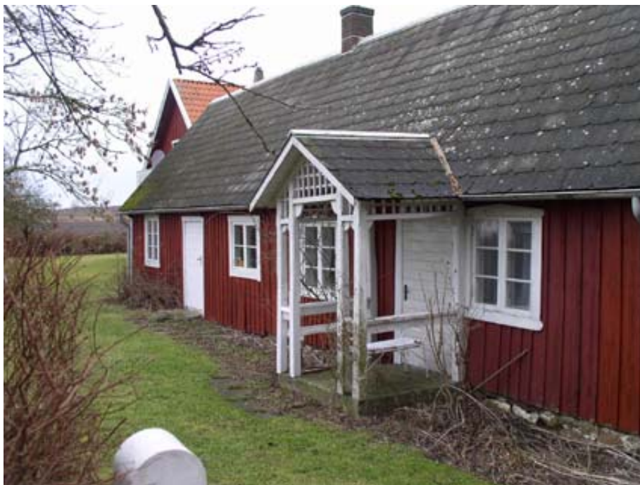
Magnarp 7:9. 1800-tals torp i anslutning till Magnarpsvägen. Långsmal långa klädd med rödfärgad locklistpanel.
