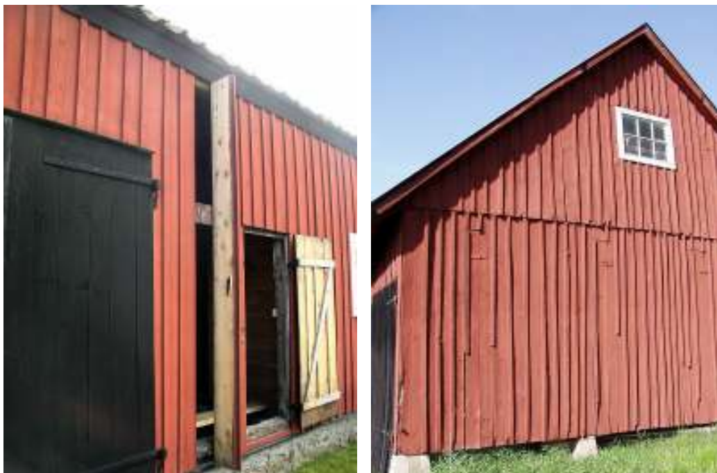
Bilder från en torklada i Åhus med öppen lucka och från en torklada i Rinkaby med stängda långsmala luckor.
