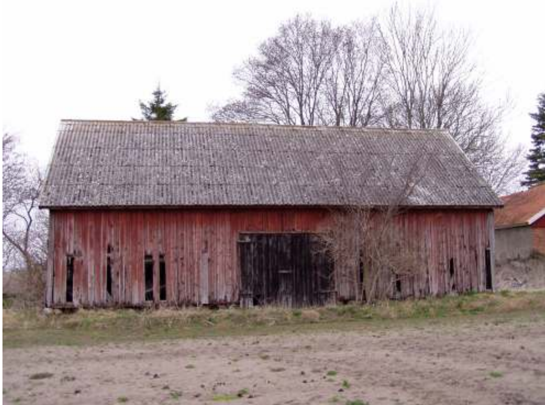
Tobaksladorna är betydelsefulla för både vår kulturhistoria och det liv som finns i landskapet, men de behöver en funktion. Ovan vänster; Eldtorkningslada i Gringelstad. Ovan höger; Hål för slangar till ångpanna som idag ger busrum till fåglar. Nedan; Torklada i Legeved uppförd omkring 1900 med kallmurad grund, regelverk och glesad panel samt stickspånstak.
