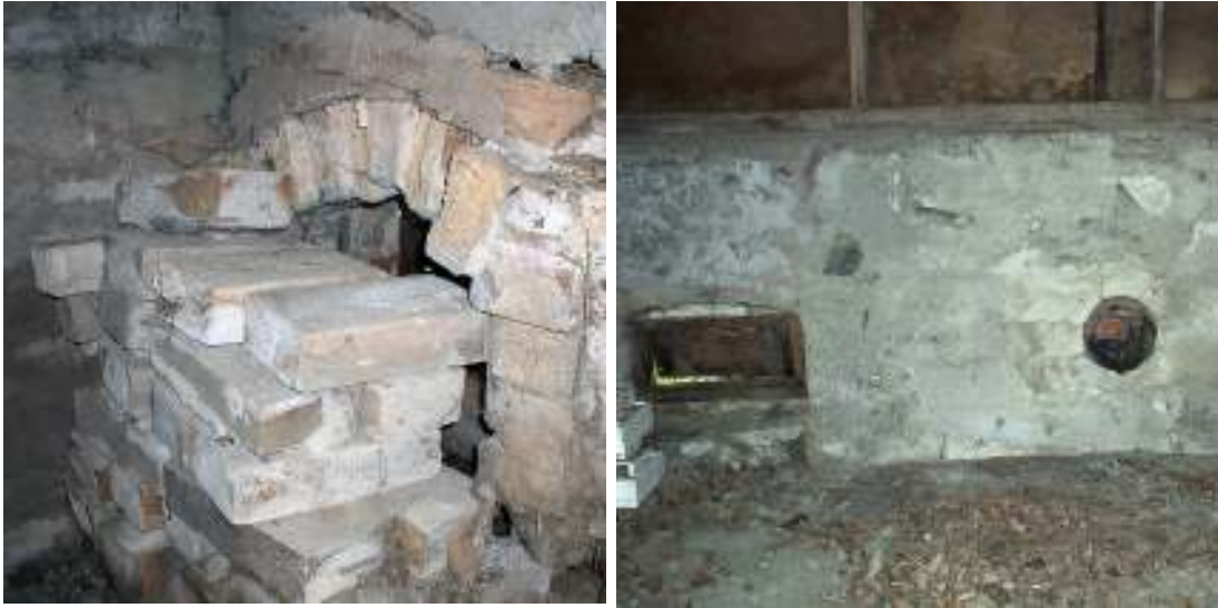
Bilder från eldtorkningslada för värmestorkning i Kiaby med raserad ugn, ventilationslucka och hål för rör till skorstenen.
