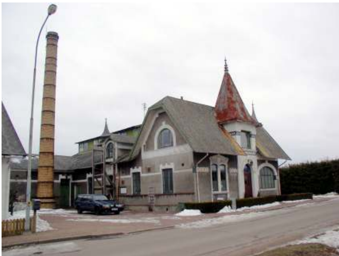
Mejeriet i Höganäs är ett av länets bäst bevarade med skorsten, lanternin, lastbrygga och isbus kvar.
