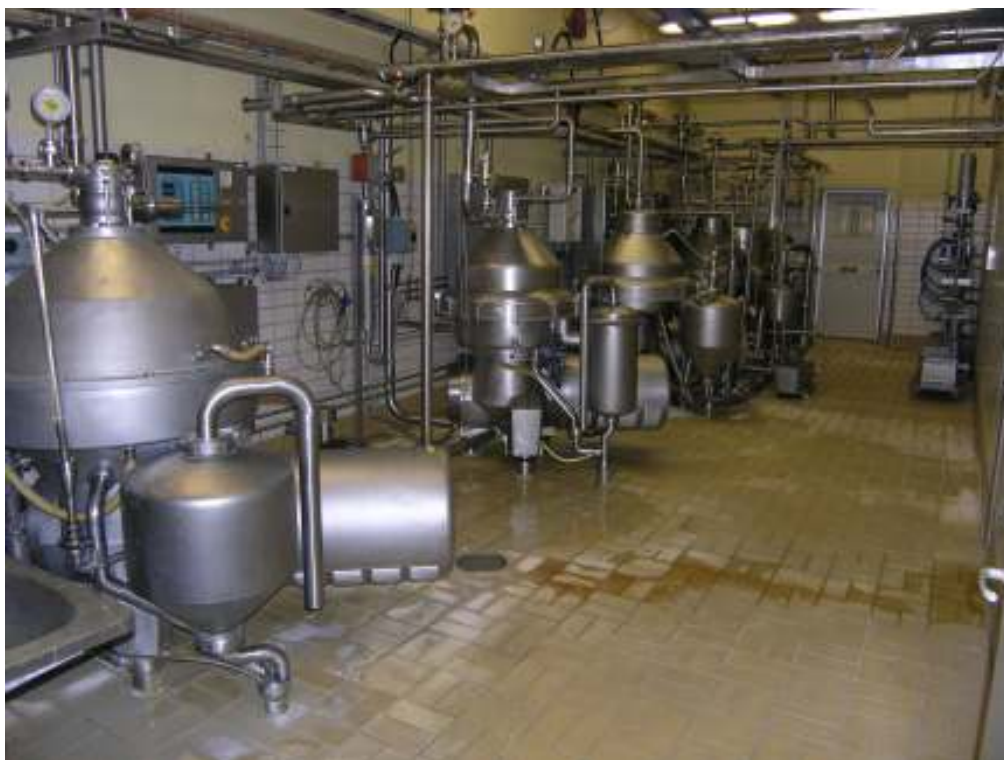
Interiör från separatorrummet i Hörby ostmejeri.
