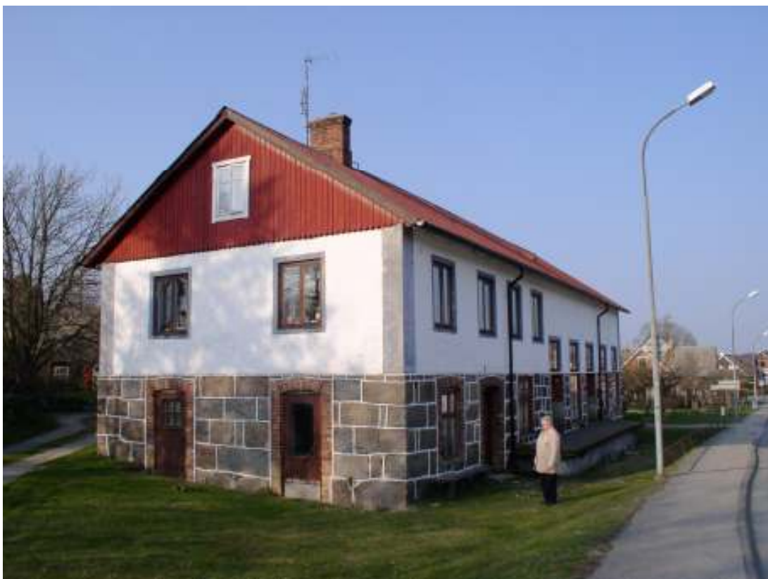
Mejeriet i S:t Olof har en sockel av buggen natursten och putsade tegelfasader, på gården finns uthus i trä samt en skorsten.
