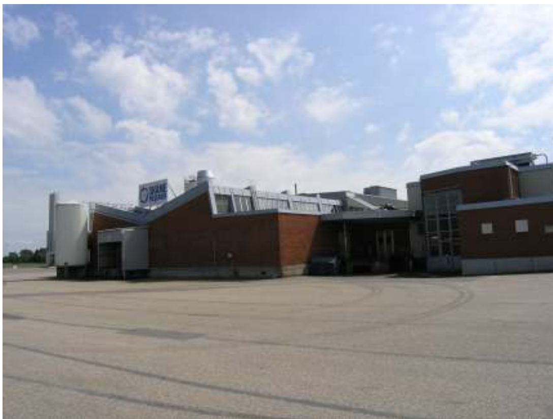
Lunnarps kärningscentral byggdes 1960 med fasader i rött tegel, motfallstak och överljus. 1966 byggdes det till med en komplett mejeriet, även senare tillbyggnader har gjorts.
