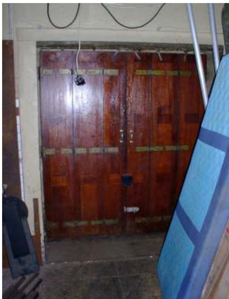
På bilden ses de typiska vikedörrarna som finns mellan mottagningen i mejeriet och lastbryggan på många mejerier, lägg märke till de räfflade gjutjärnsplattorna i golvet.
