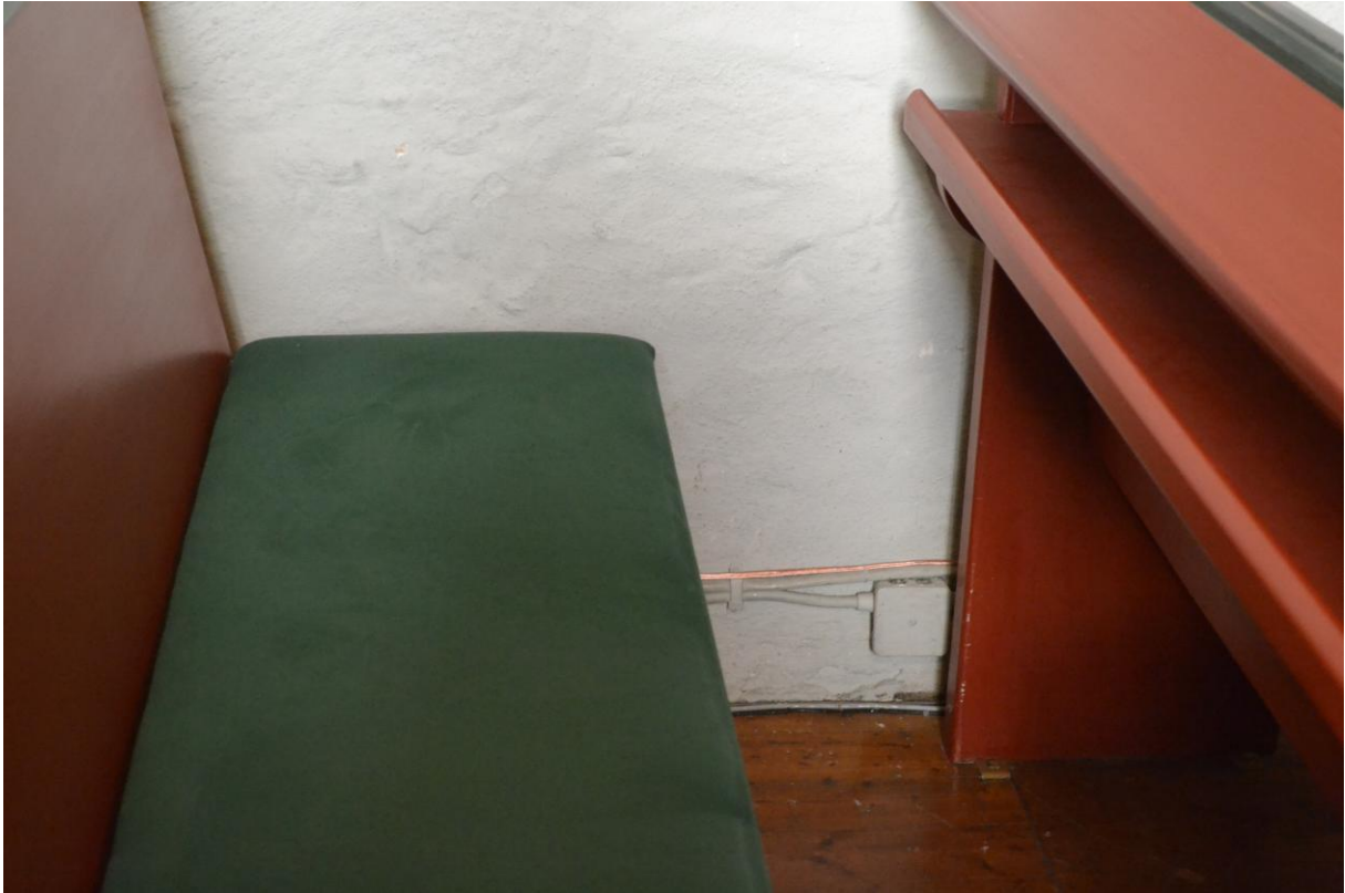
Ledningarna mellan högtalarna drogs intill redan befintliga kablar.
