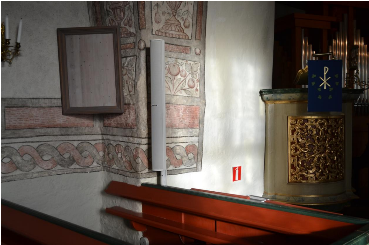
Överst: De nya högtalarna på norra långsidan, dels i en fönstersmyg, dels intill väggen vid övergången mot koret. Ledningen till högtalarna i fönstret kommer att målas in i färg. Nederst: De främre högtalarna placerades på fristående stativ.
