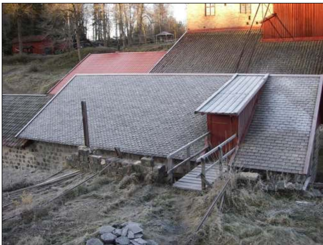
Östra sidans takfall efter åtgärder
