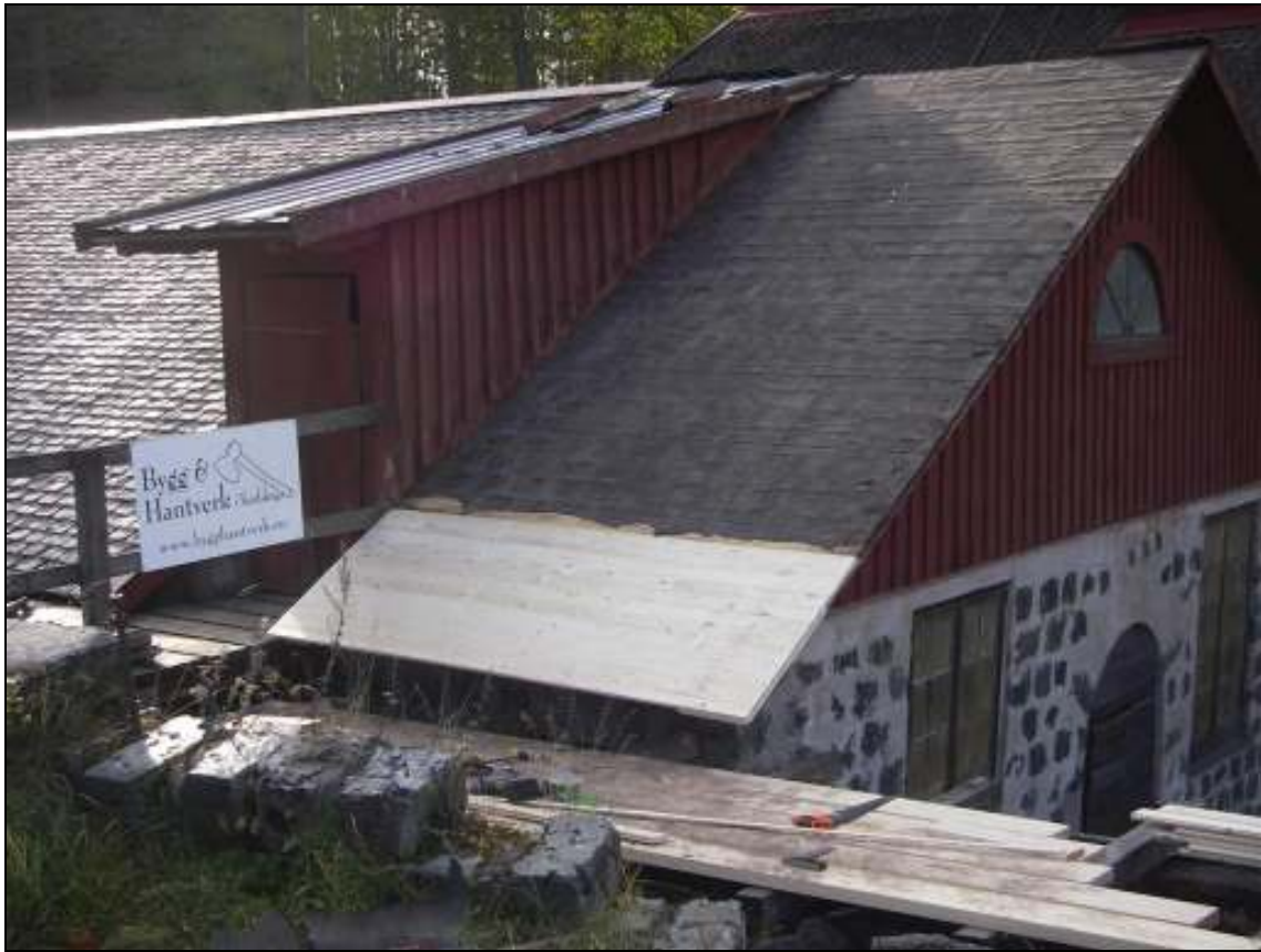
Takpanelen samt taktassen är lagad
