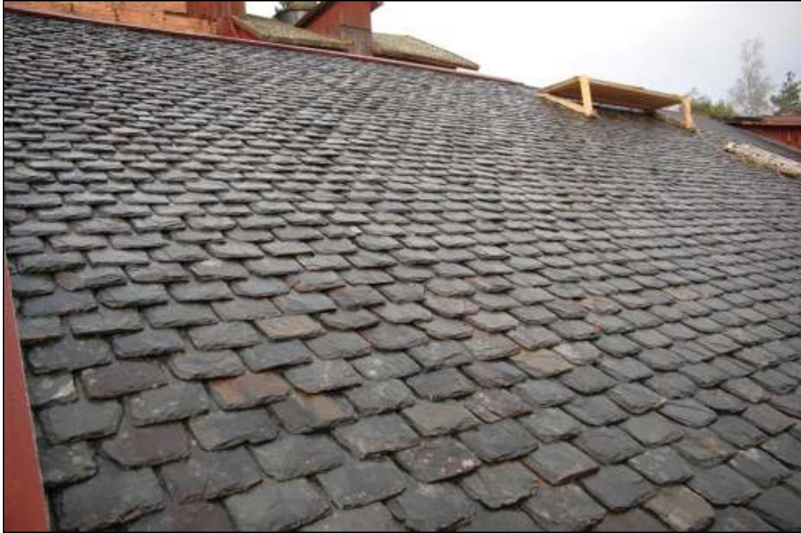
Monteringen av skiffret på vänstra sidan är nästan färdig
