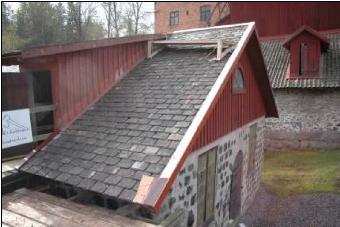
Högra sidan efter att skiffret monterats och brädor kommit på plats. Vindskivan har målats med Falu rödfärg och behandling av vattbrädan med rödtjära har påbörjats.
