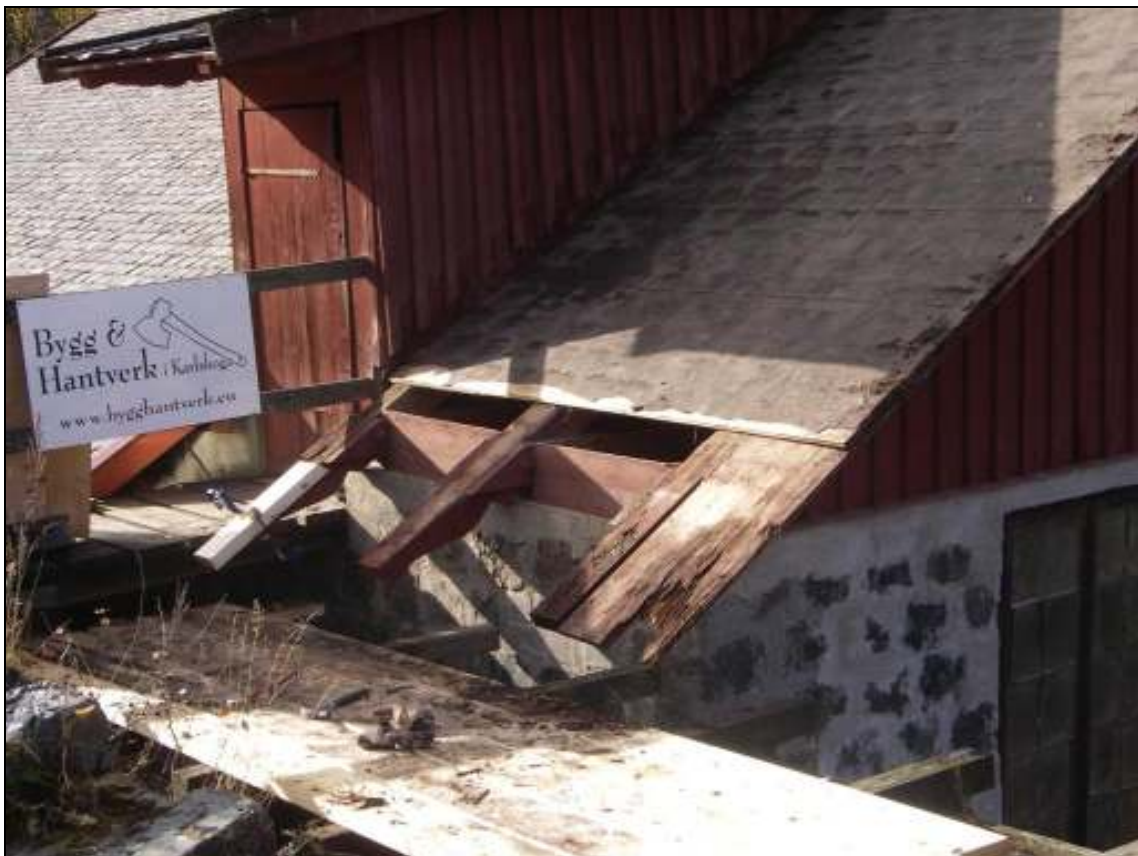
Lagning av taktass och takpanel pågår
