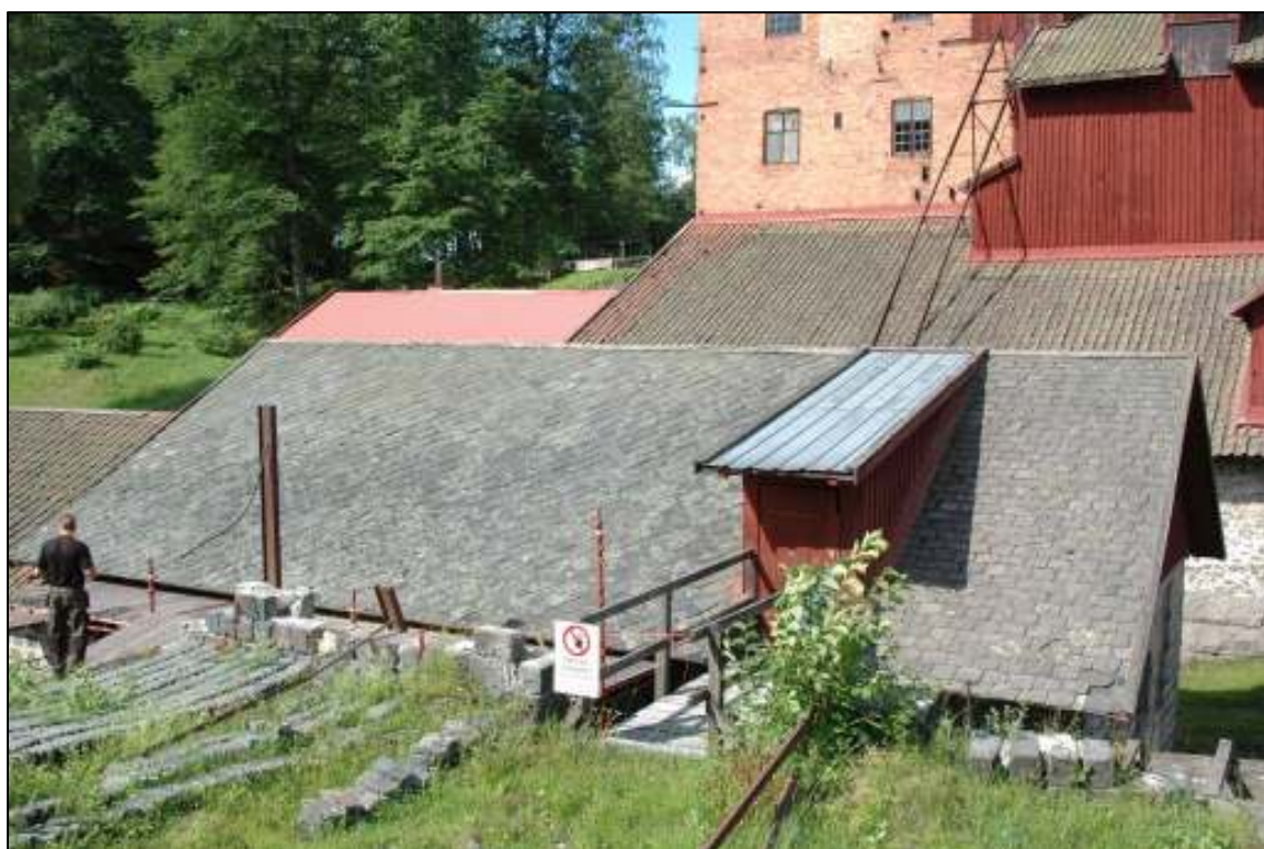
Östra takfallet före åtgärder
