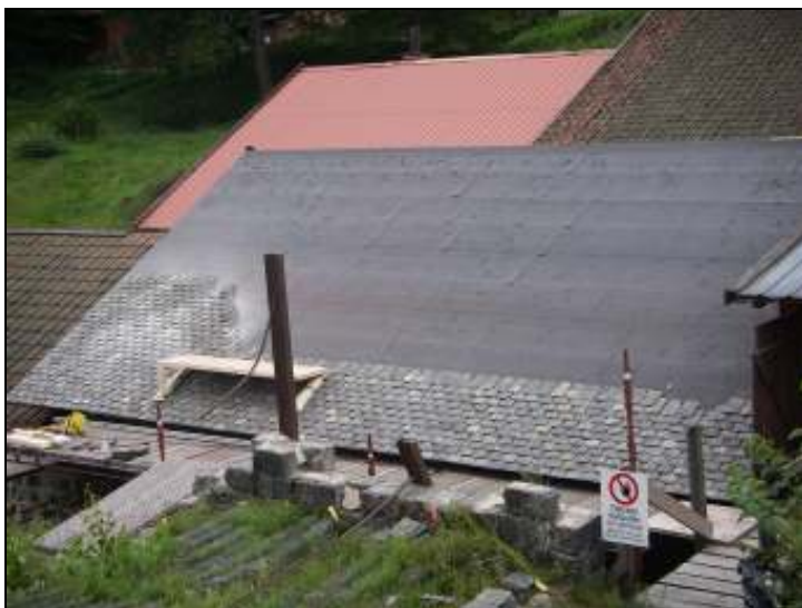
Monteringen av det nya skiffret är påbörjad
