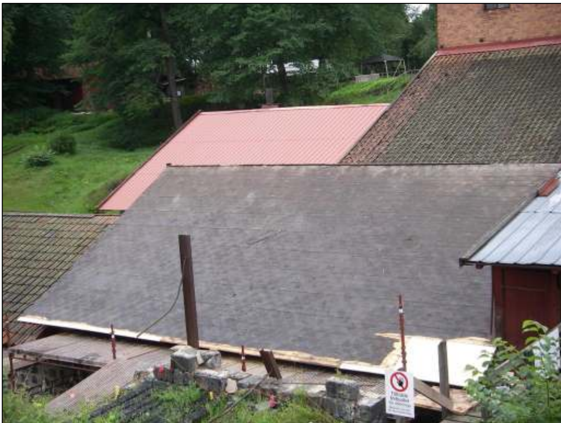
Takpappen är blottlagd och den rötskadade panelen är lagad
