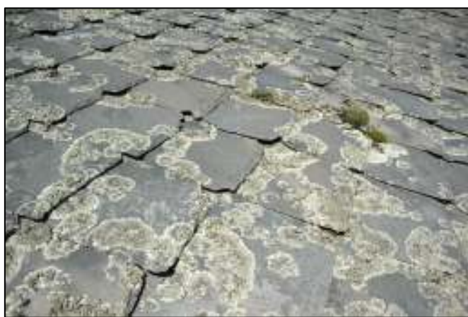
Det befintliga skiffret bevuxet med lav
