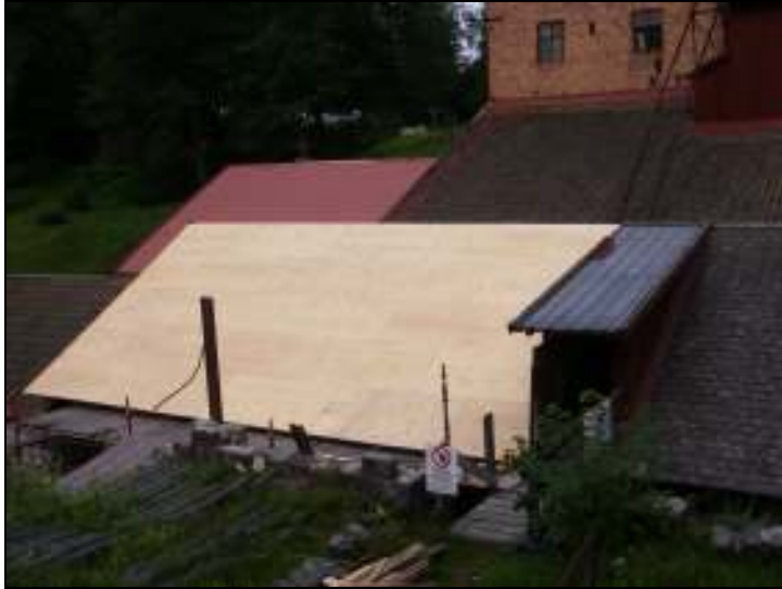
Underlagsplywooden är monterad
