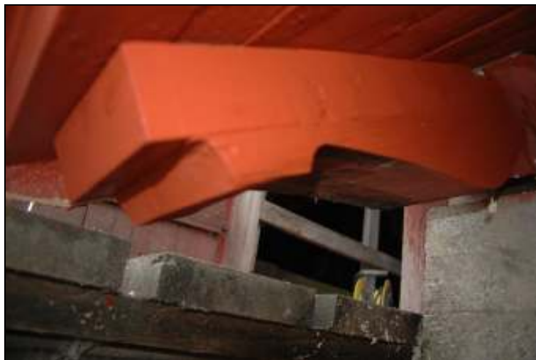
Den lagade taktassen efter åtgärd
