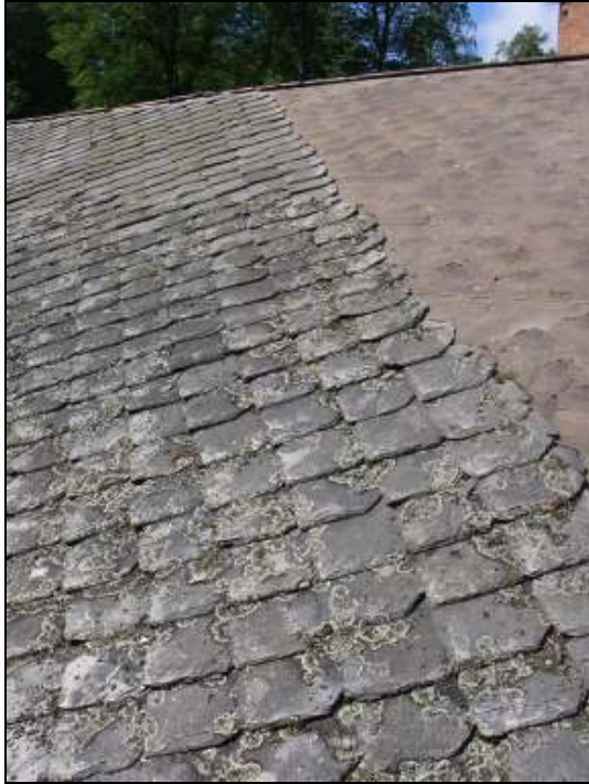
Del av befintligt skiffer under nedtagning
