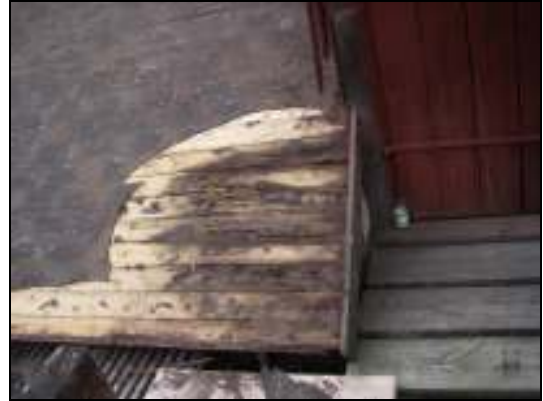
Rötskadad takpanel
