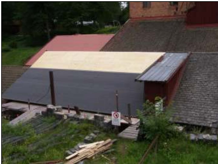
Plywooden kläddes med papp som lades i våder
