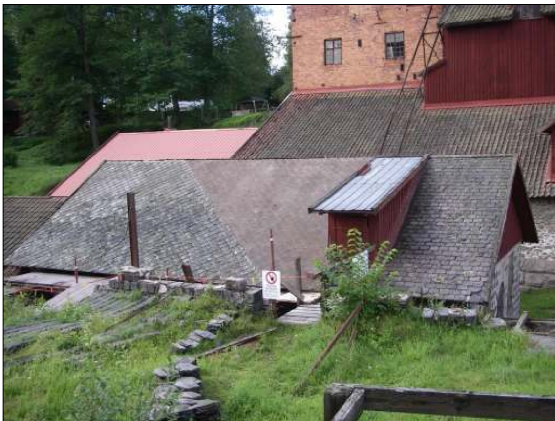
Nedtagning av det befintliga skiffret har påbörjats
