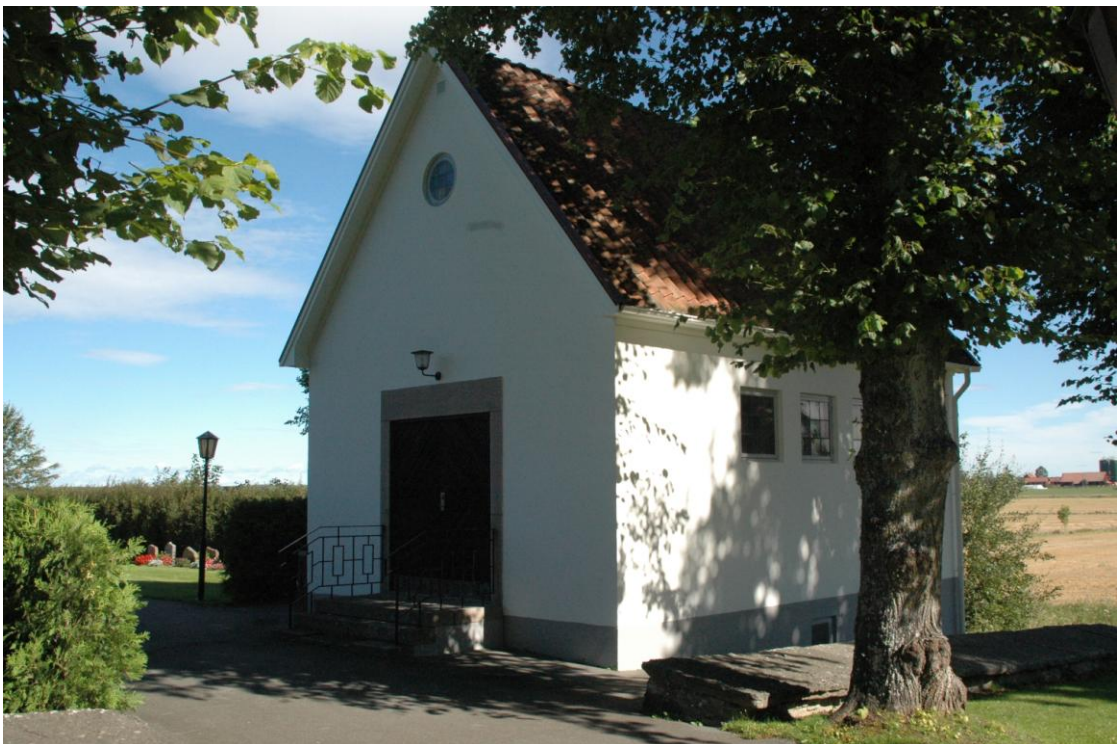
Ekeby gravkapell efter renovering
