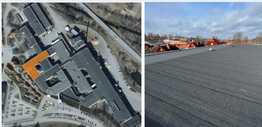
Bild 13: Orangemarkerad yta visar renoverad del av taket som kan vara lämplig plats för första installationen av solcellerna. 37
