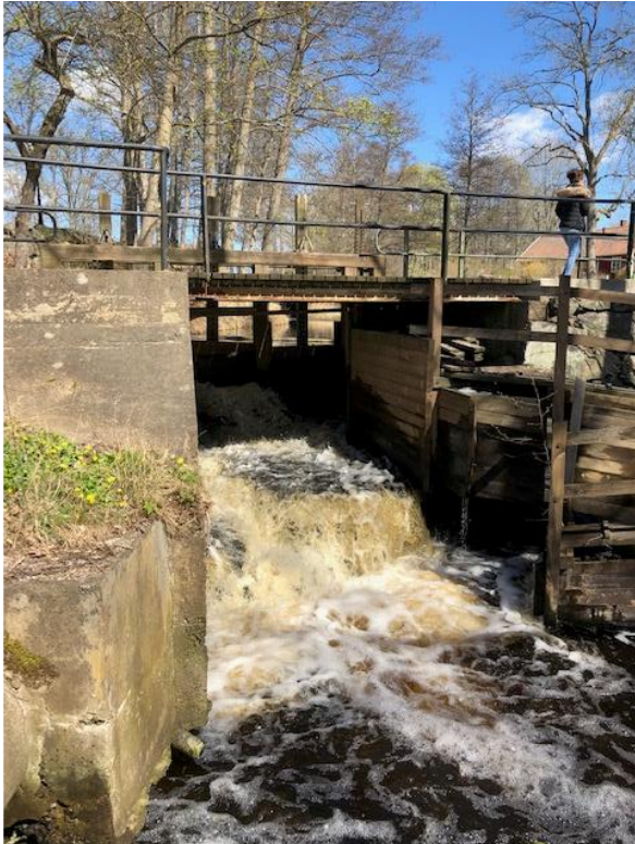
Bild: Vandringshinder vid Bubbetorp med dysfunktionell fisktrappa till höger. Foto: Andreas Holmberg
