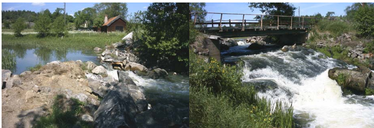
Bild 3. Den nyligen anlagda stenvallen ovan hällen (t.v.) och båda vandringshindrena (t.h.)
