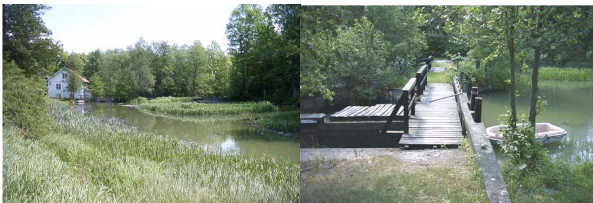
Bild 1. Spegeldammen vid Skeppsgården (t.v.) och dammanläggningen (t.h.)
