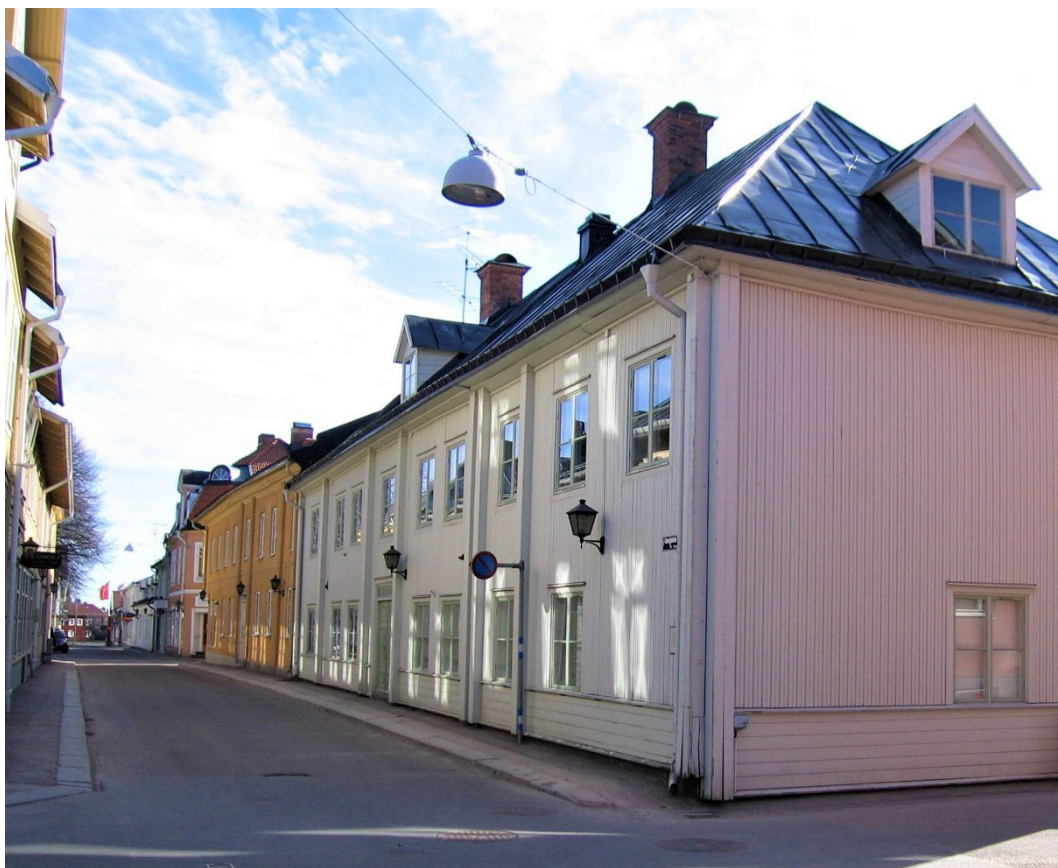
Figur 2. Huvudbyggnadens fasad mot Storgatan/ Vattugränd. Notera sockeln och knutlådorna. Foto: Länsstyrelsen i Dalarnas län.
