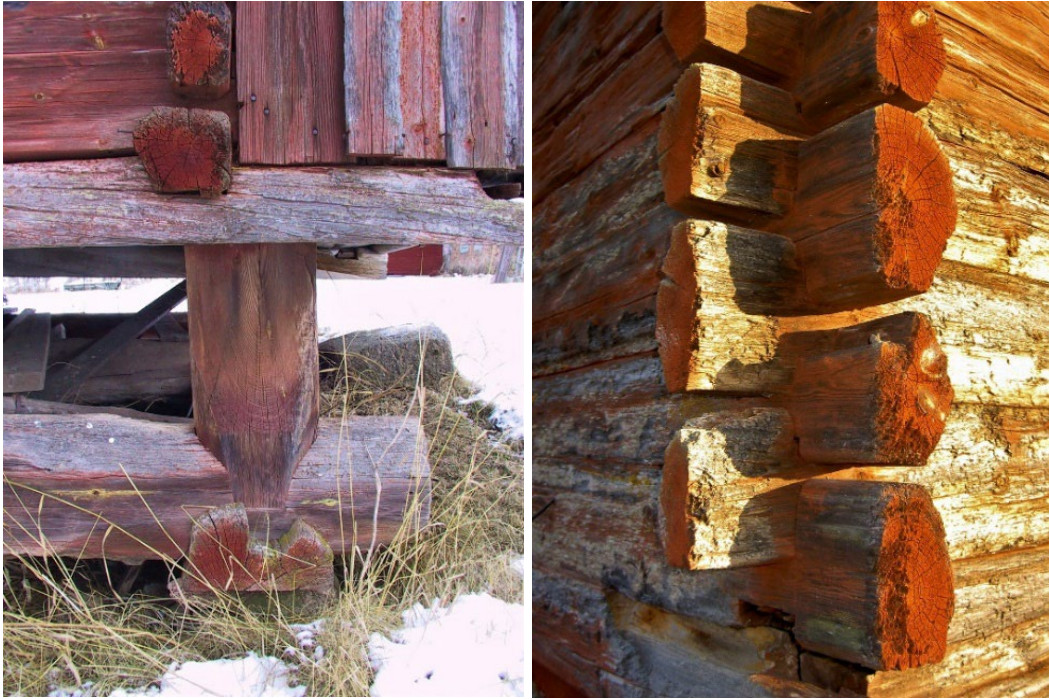
Figur 1. (Vä) Stolpkonstruktion och (hö) rödfärgade knutskallar. Foto: Länsstyrelsen i Dalarnas län.
