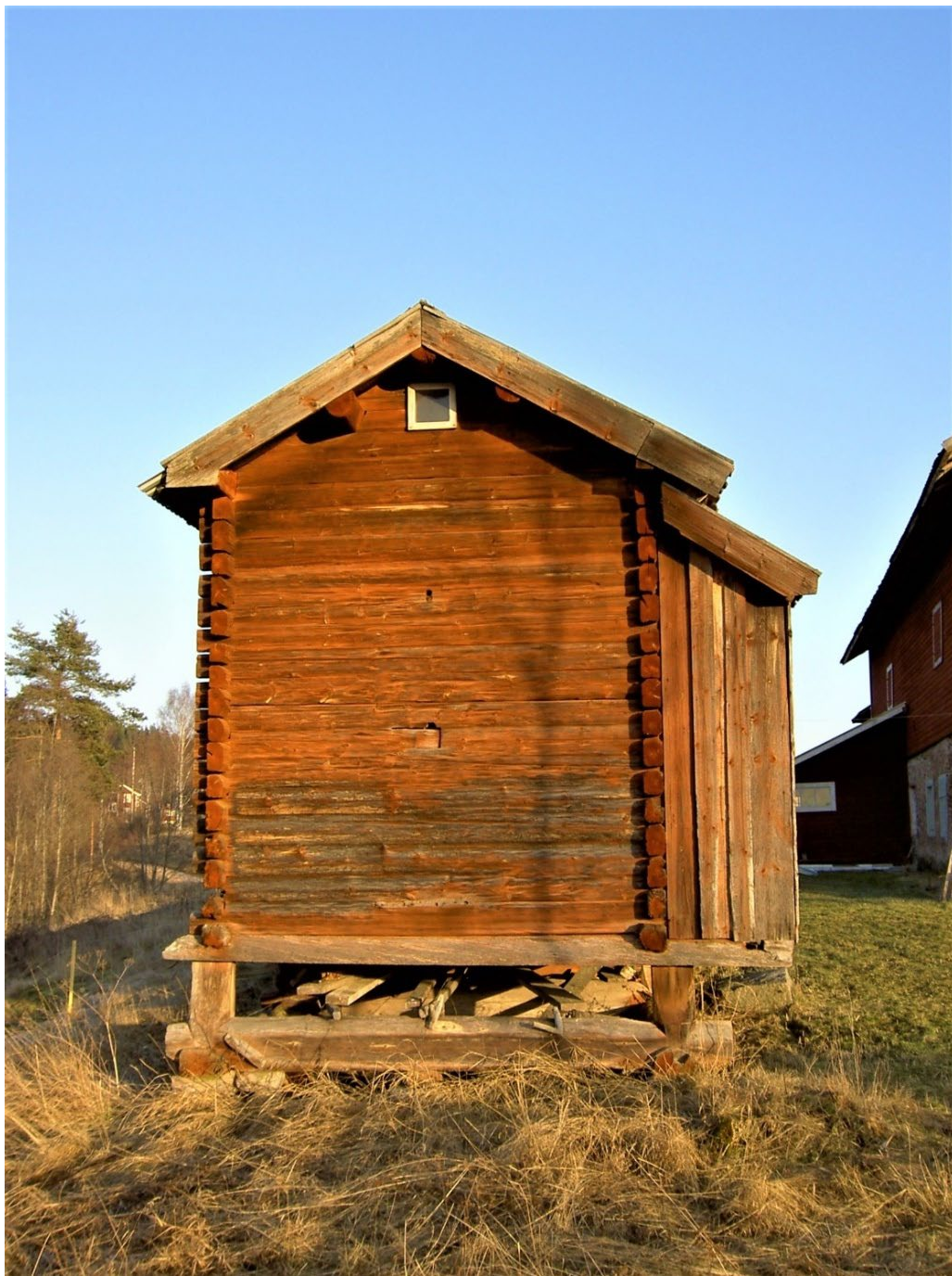
Figur 2. Gavel med glugg för ljusinsläpp högst upp i gavelröstet (fotona är tagna innan flytten av härbret till Altsarbyn). Foto: Länsstyrelsen i Dalarnas län.
