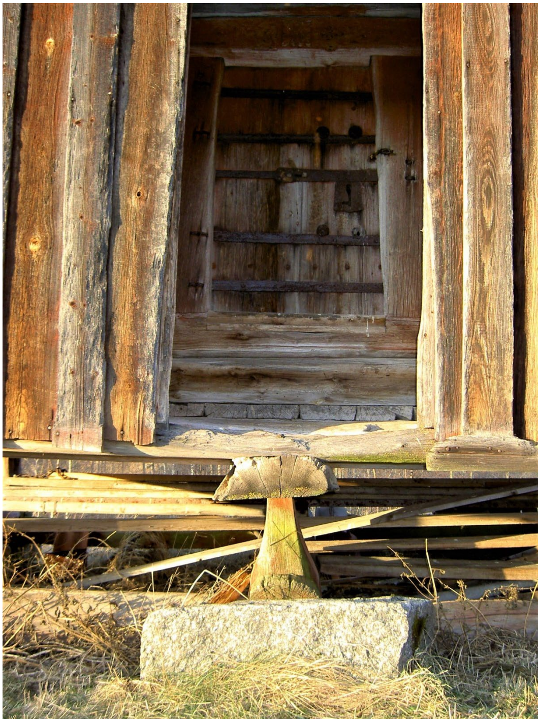
Figur 4. Ingången till svalen och den breda bräddörren med bandgångjärn. Foto: Länsstyrelsen i Dalarnas län.
