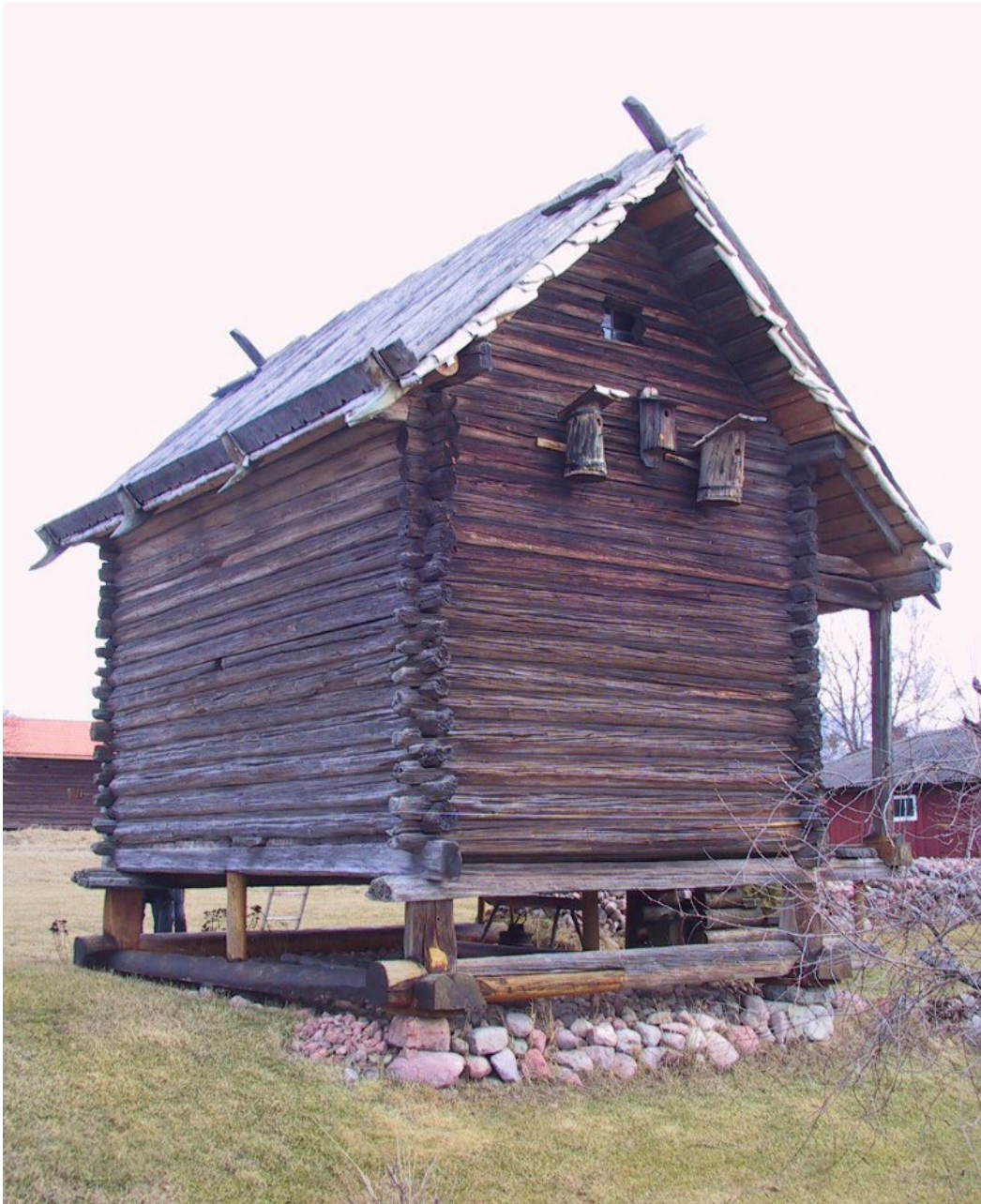
Figur 5. Härbret har ovanligt brant takfall. Foto: Länsstyrelsen i Dalarnas län.
