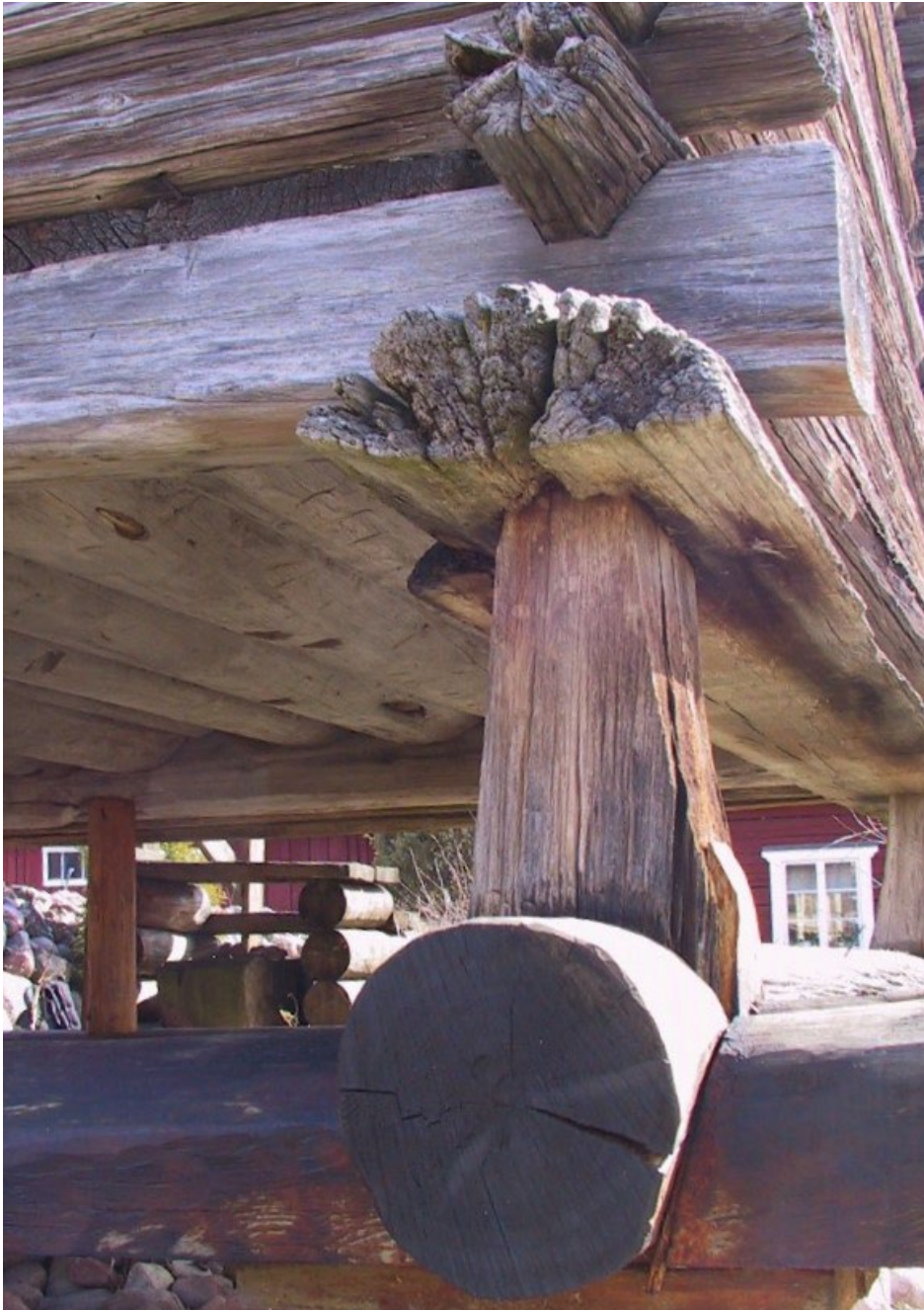
Figur 7. Stolpkonstruktion med mushylla. Foto: Länsstyrelsen i Dalarnas län.
