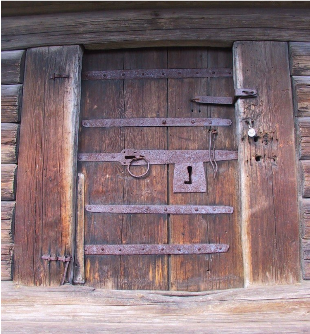
Figur 6. Bräddörren med handsmidda beslag. Foto: Länsstyrelsen i Dalarnas län.
