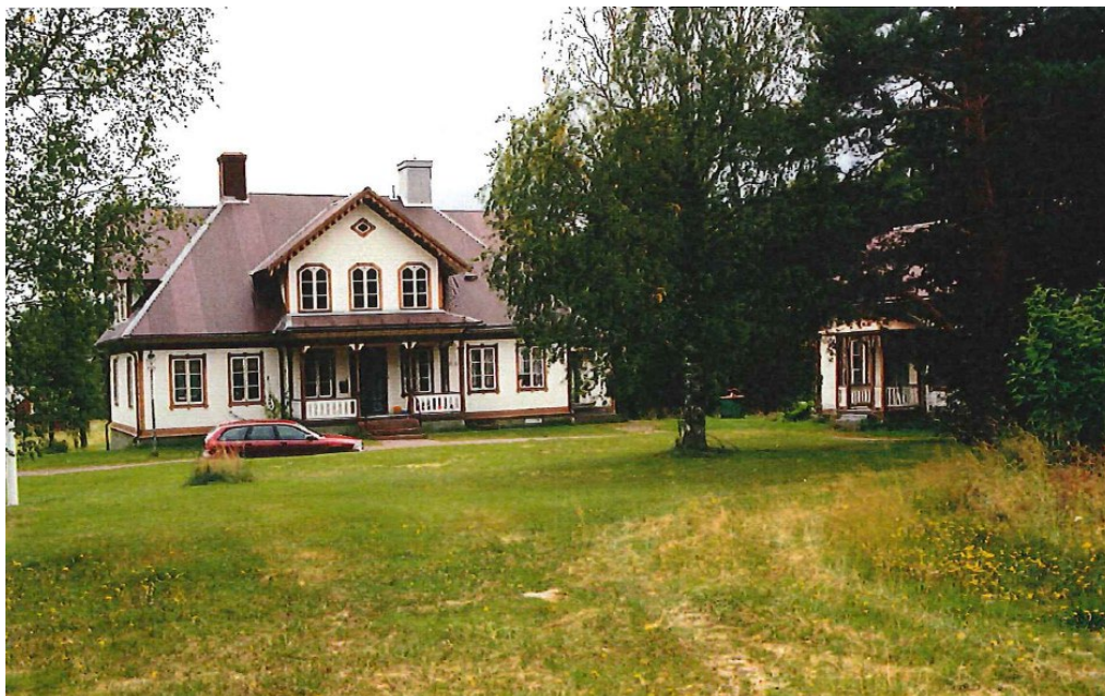
Figur 2. Mangårdsbyggnaden sedd från ladugården.
