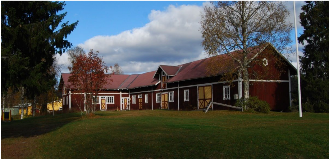
Figur 3. Ladugårdsbyggnaden. Foto: Länsstyrelsen i Dalarnas län.
