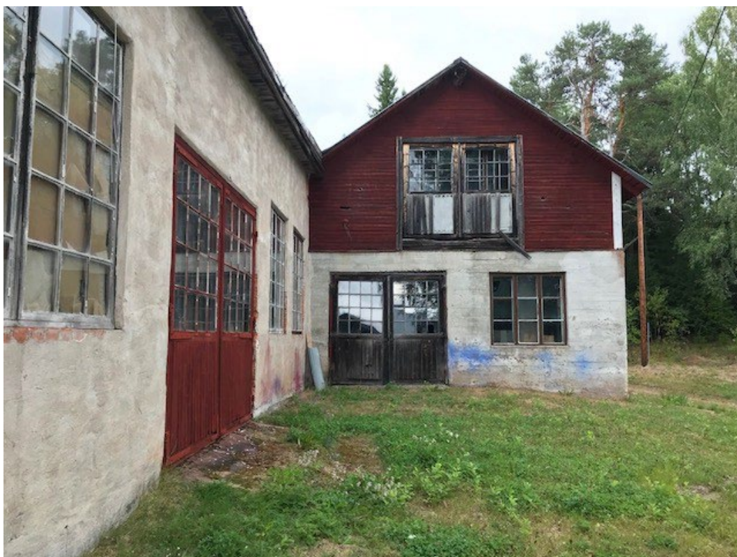
Figur 5. Putsade fasader och stora fönster för maximalt ljusinsläpp. Foto: Anna Hagland, Länsstyrelsen i Dalarnas län.
