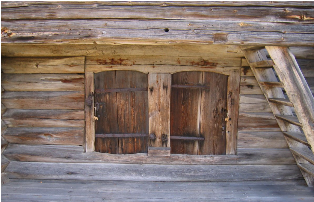
Figur 4. Dörrar med draglås i loftbodens norra del. Foto: Länsstyrelsen i Dalarnas län.
