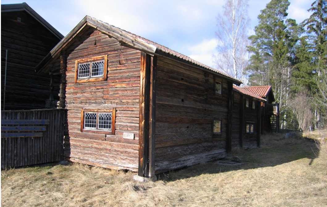
Figur 3. Baksidan av loftboden med fönster med blyinfattat glas, ett senare tillägg. Foto: Länsstyrelsen i Dalarnas län
