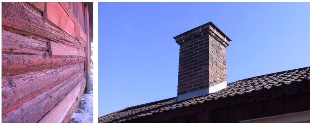
Figur 7. Rundtimrad yttervägg i vagnslidret till vänster och bostadshusets ena skorsten till höger. Foto: Länsstyrelsen i Dalarnas län.
