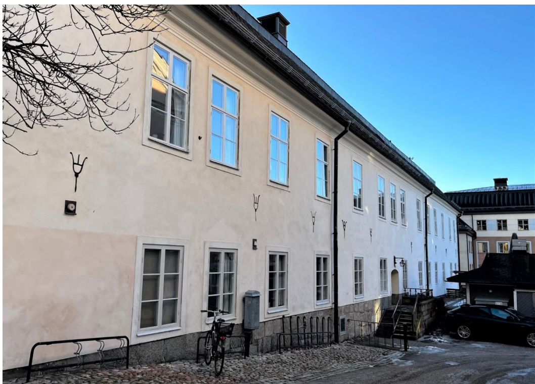
Figur 4. Rådhusets baksida mot norr. Notera ankarslutarna. Foto: Lovisa Lindberg, Länsstyrelsen i Dalarnas län.
