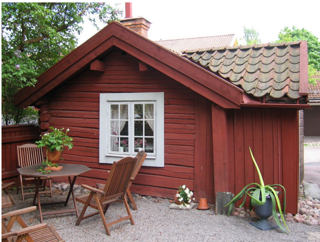
Figur 1. Gaveln mot gården med rödfärgad fasad, vindskivor och knutar. Till höger det panelade vindfånget. Foto: Länsstyrelsen i Dalarnas län.
