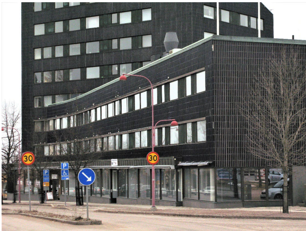
Figur 2. I bottenvåningen syns skyltfönster ut mot gatan. Foto: Länsstyrelsen i Dalarnas län.
