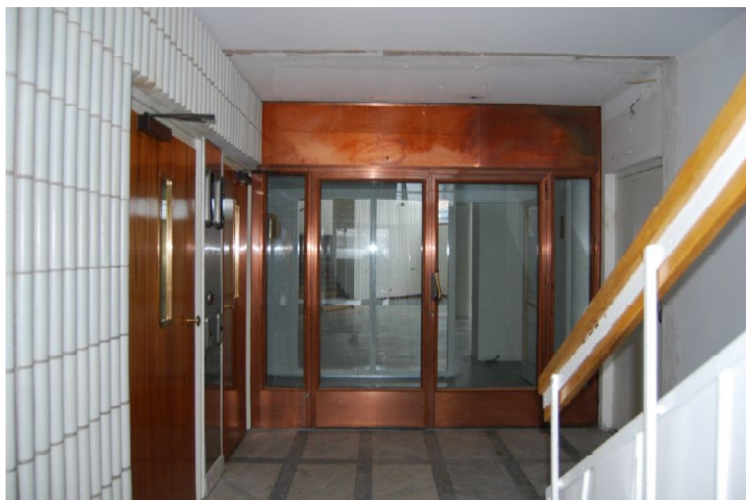
Figur 7. Dörrparti utfört helt i koppar och glas. Keramikstavar på väggen till vänster. Foto: Länsstyrelsen i Dalarnas län.
