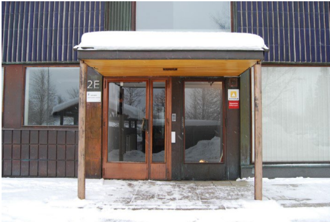
Figur 4. Påkostad entré utförd i kopparplåt. Foto: Länsstyrelsen i Dalarnas län.
