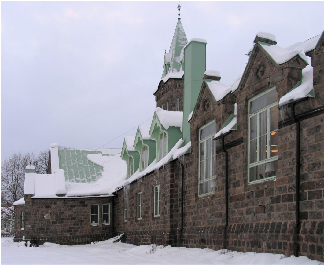
Figur 4. Stora fönster för maximalt ljusinsläpp i lektionssalarna. Foto: Länsstyrelsen i Dalarnas län.
