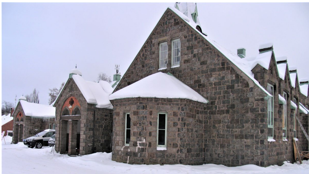
Figur 3. Entrépartierna är särskilt utsmyckade med orneringar i tegel och specialgjuten slagg. Foto: Länsstyrelsen i Dalarnas län.
