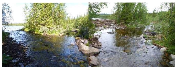
Bild 2. Utloppet ur Gäddsjön. T.v. förebild där kanaliseringen syns tydligt till vänster. T. h. efterbild där kanaliseringen pluggats igen och allt vatten nu strömmar i den ursprungliga fåran till höger i högra bilden. Foto: Magnus Lindberg, Länsstyrelsen Västerbotten.
