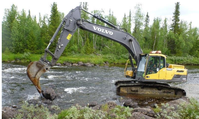
Bild 4. Varsamt och med skicklighet läggs block tillbaka i Marsån. Grävning utförs av Fjällströms AB. Foto: Magnus Lindberg, Länsstyrelsen Västerbotten.
