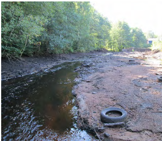
Figur 4. Damområdet vid Stendalsmölle direkt efter avsänkning av dämnet.
