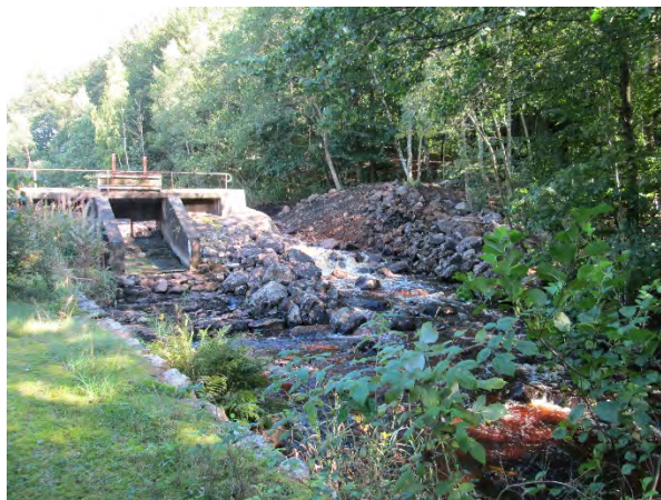
Figur 2. Sommaren 2014 öppnades dammvallen upp och dammen sänktes av.
