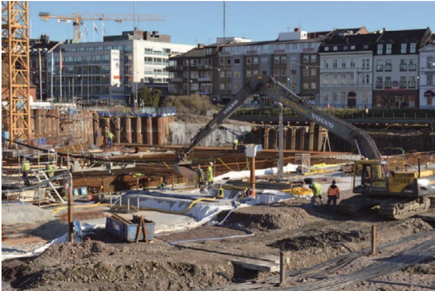
Malmö Live under uppbyggnad.
