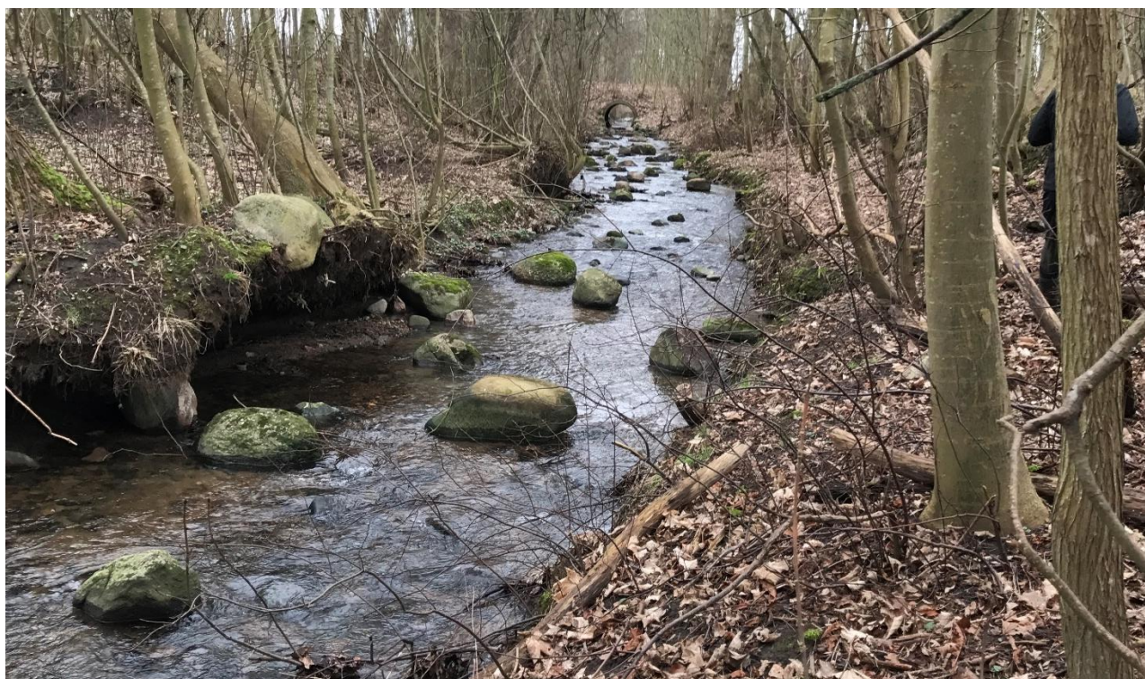
Bild: Exempel på blockrestaurerad stömsträcka vid Västregård i Kövlebäcken, Råån. Block och sten har tagits från rensvallar längsmed strandkanten och lagts tillbaka i fåran.
