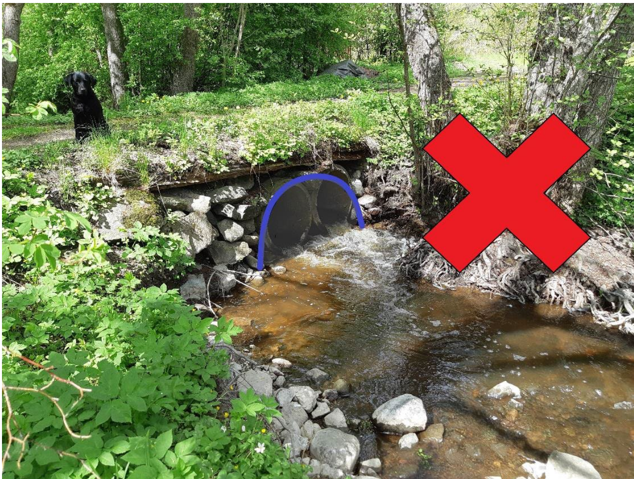
Bild 2. Bilden visar en fellagd brotrumma som inte fungerar för fiskar.
