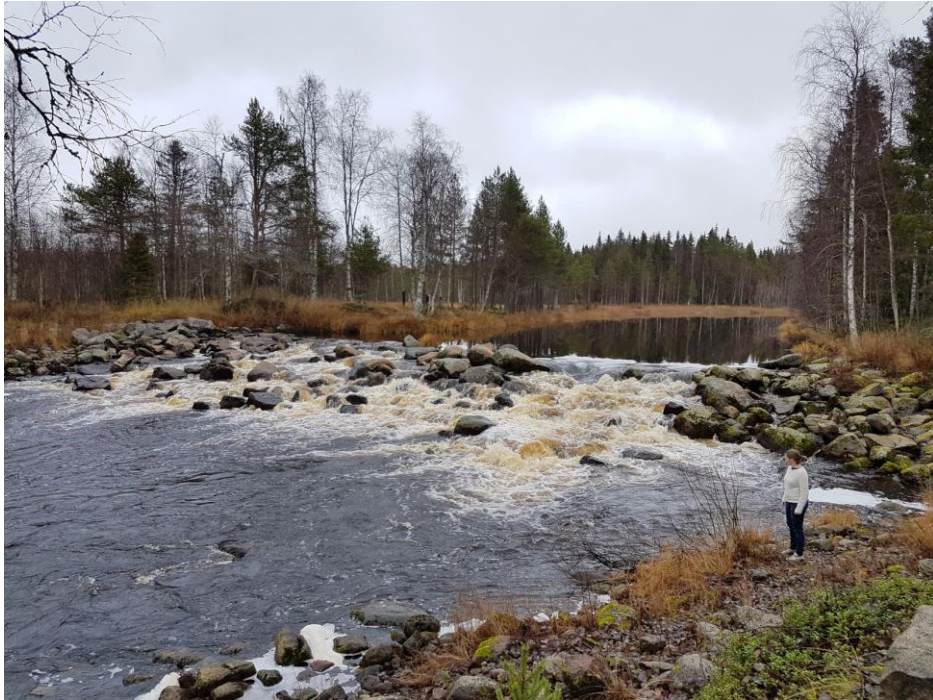
Stentröskel i utloppet av Teurajärvi. Foto: Länsstyrelsen i Norrbotten.
