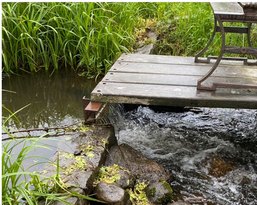
Figur 1. Järnbalks- och träkonstruktion vid ingången till omlöpet vid Vinbergs Kvarn.
