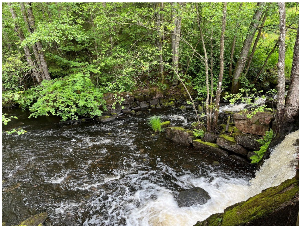
Figur 4. Översikt som visar utskovet till höger i bild samt ovan syns rännan som nu agerar fiskväg.
