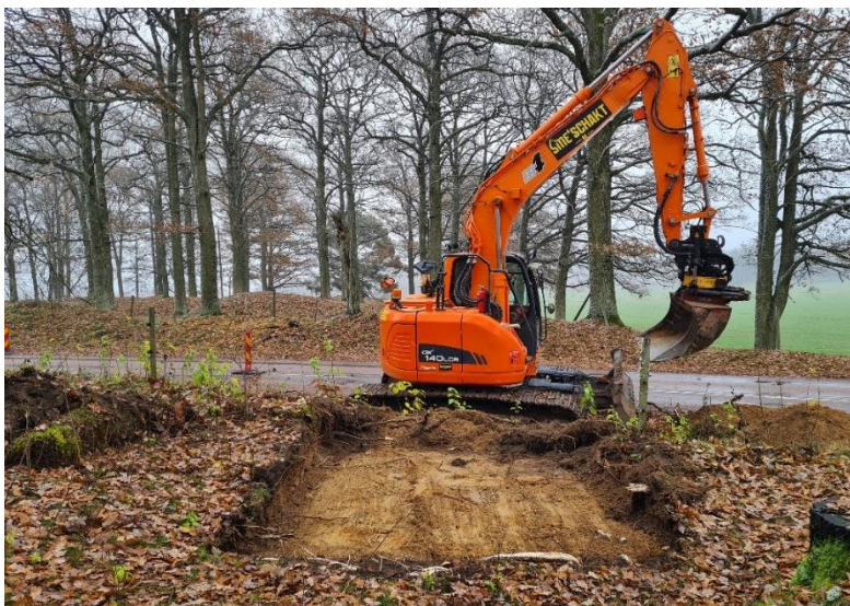
Figur 9. Sökschaktning vid yta 2. Foto från Ö.
