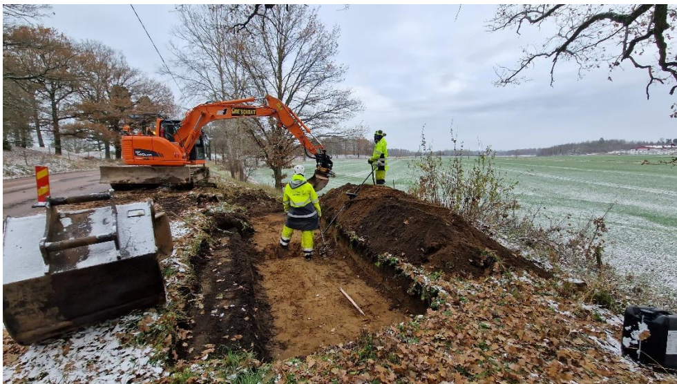
Figur 12. Yta 4. Sökschaktning vid stensättningen L2021:1070. Foto från S
