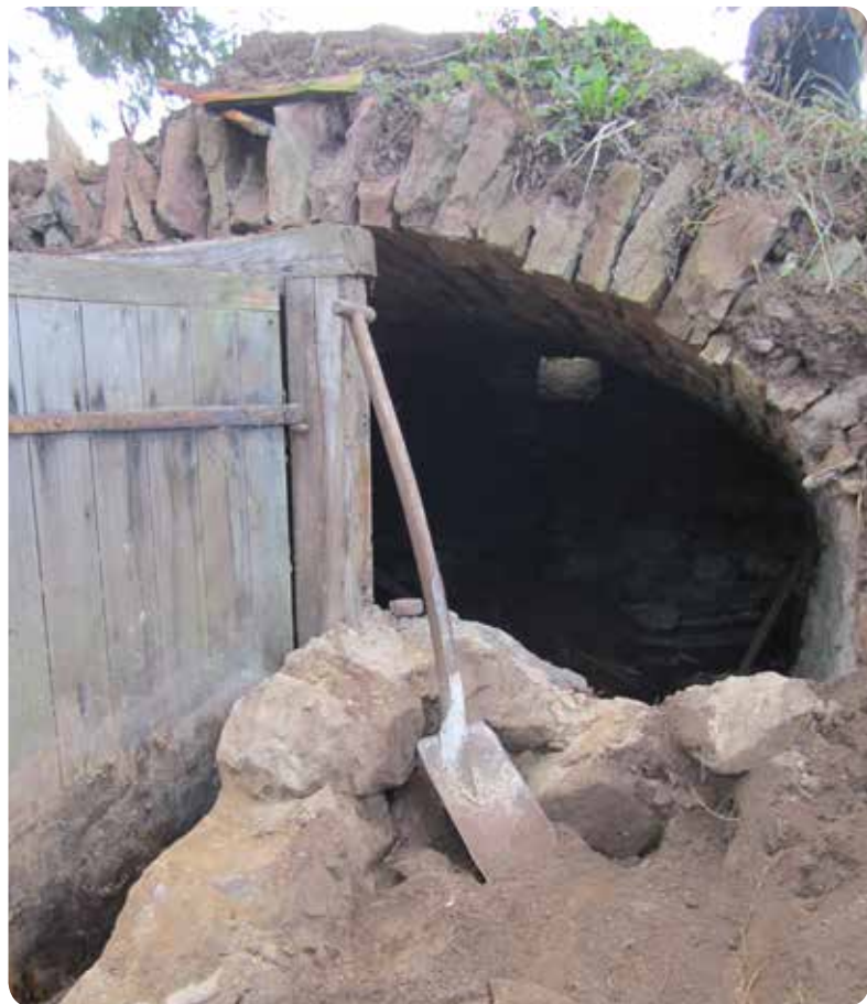
Frontmuren med svalen tas ned för att restaurera valvet på Ambjörnstorp. På bilden syns att murarna är fristående från varandra och potatishålet syns i bakmuren.
