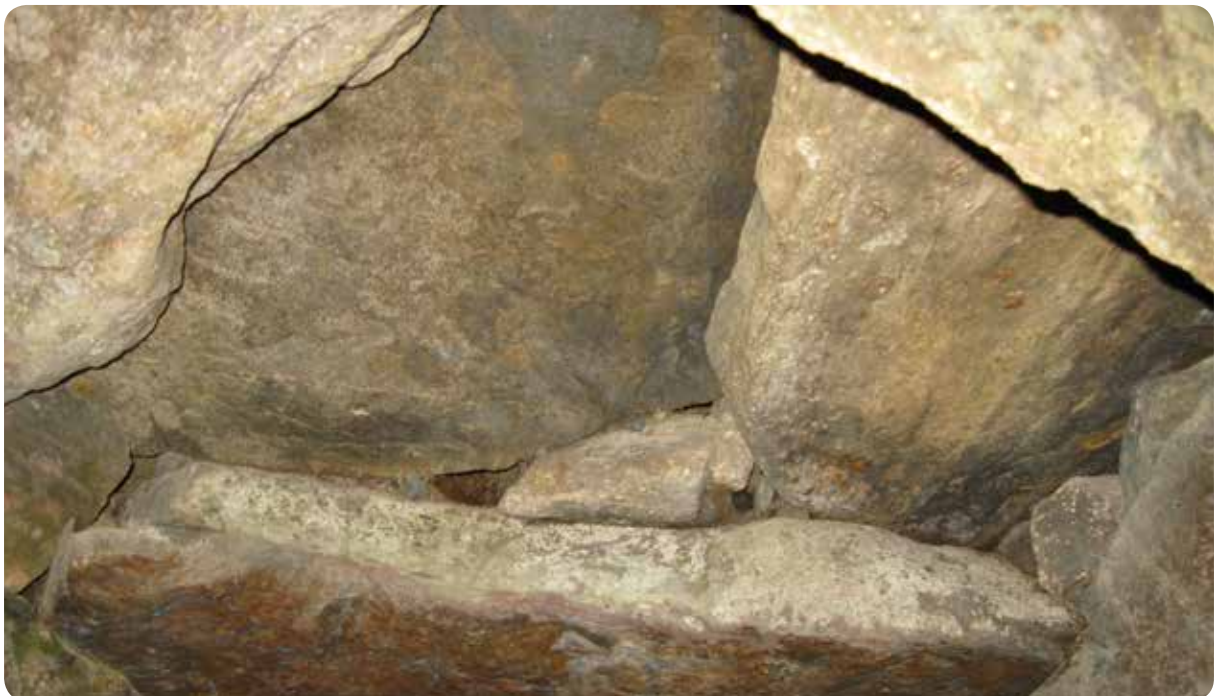
I varje skift förskjuts de flata stenarna lite inåt mitten och tar stöd på det underliggande lagret. Foto: Karin Nordström, Göteborgs Stadsmuseum.
