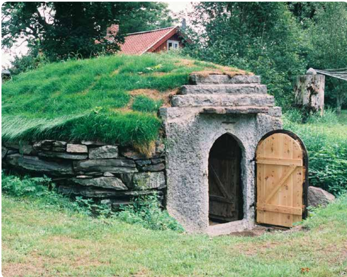
I Skaraborg var det vanligt att man använde kalksten i färdighuggna "moduler" för att bygga en jordkällare. Nyrestaurerad jordkällare, Ekebo gård. Foto: Ulf Larsson, Västarvet.
