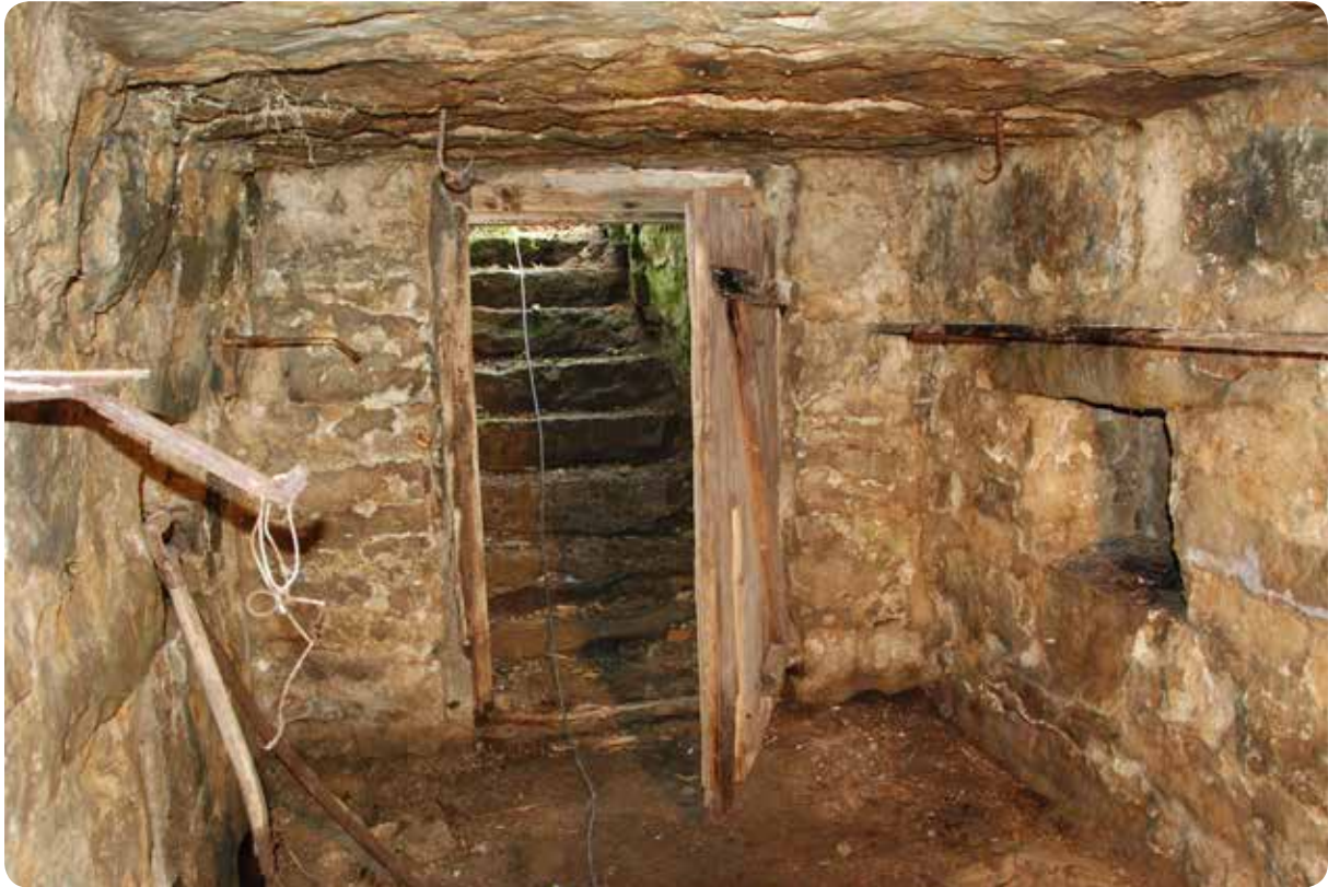
Stora stenhällar bildar taket och ligger på källarens stenväggar. Jordkällaren är nedgrävd på plan mark med en trappa som leder nedåt. Värkumla. Foto: Emma Östlund, Länsstyrelsen i Västra Götalands län.
