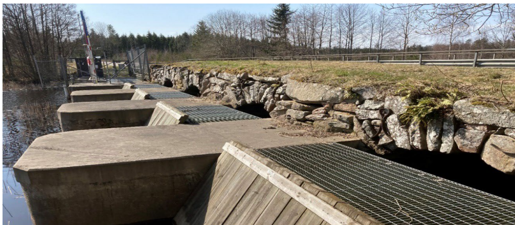
Figur 24. Kungsbro vid Huskvarnaåns utlopp från sjön Ylen. Ett exempel på en ovanlig kombination av vattenreglering med stöd av äldre stenvalvsbro i kombination med en närliggande modern vägbro. Stenvalvsbron är registrerad i RAÄ Kulturmiljöregister som forn lämning (L1972:1844) 76 .
