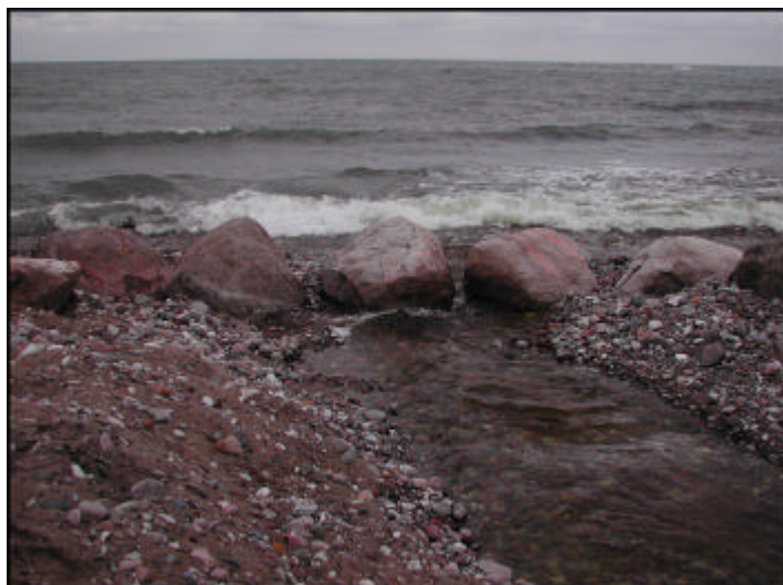
Bild 28. Stora stenblock har placerats ut i Halsegårdaån i ett försök att hindra mynningen från att svallas igen.
