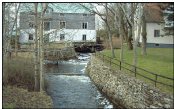
Bild 15. Ca 75 meter uppströms mynningen hindras vandrande fisk från att gå upp i ån av ett definitivt vandringshinder i form av ett sågverk.
