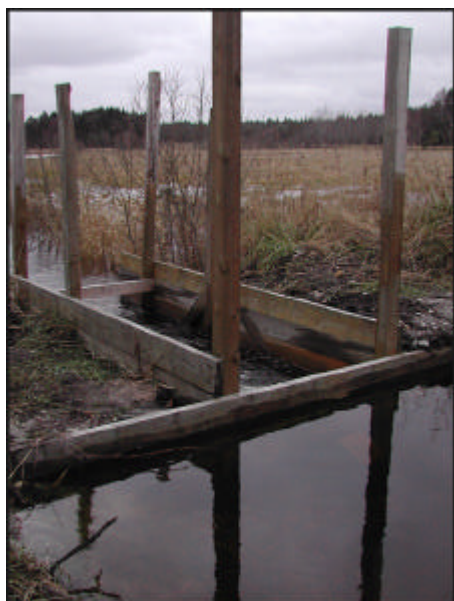
Bild 29. Ett konstgjort dämme i Lavasån. Konstruktionen dämmer vattnet i en uppströms liggande våtmark samtidigt som den tillåter fiskpassage i båda riktningarna.
