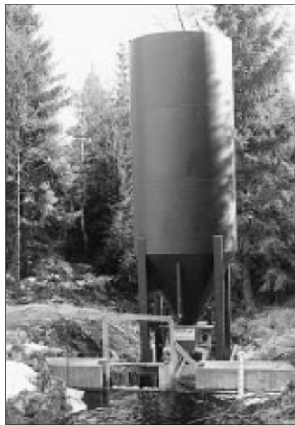
Kalkningen görs med olika metoder. I rinnande vatten passar det ofta bra med kalkdoserare som automatiskt portionerar ut kalken.
