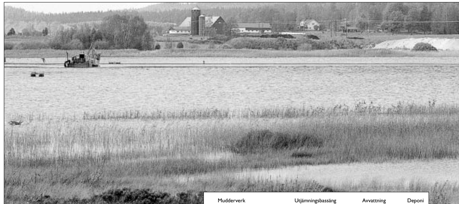
Saneringen av Järnsjöns botten gjordes med hjälp av ett speciellt mudderverk, här i arbete ute på sjön. FOTO: THORSTEN JANSSON
