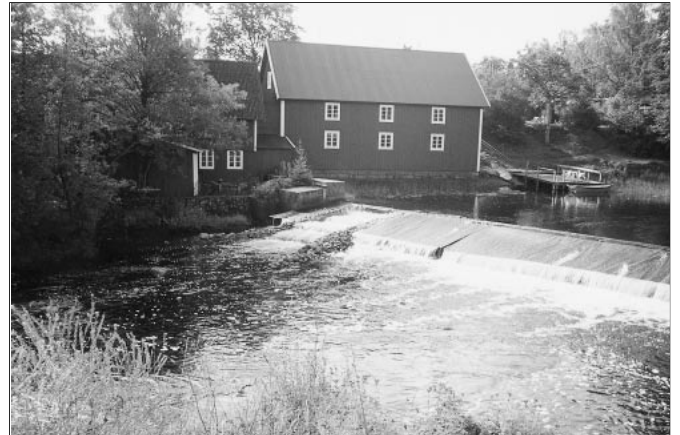
Vid Gunnarström i Ålem har åfåran gjorts i ordning för att underlätta fiskens uppvandring. Fiskvägen kan ses som en smal fåra längst bort i bilden.
