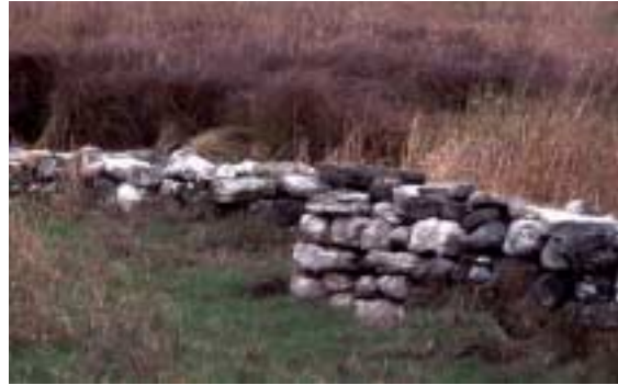
Dubbeltmur av kalksten, delvis restaurerad.
