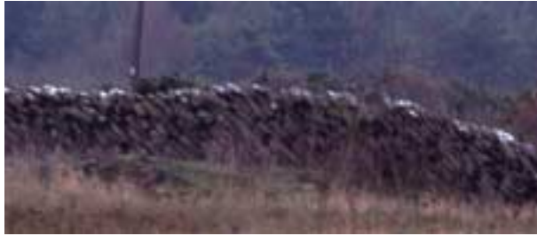
Stupställd flismur, Källa socken. Foto: A-C Magnusson
