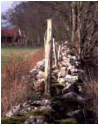
Skalmur med kompletterande taggråd.
