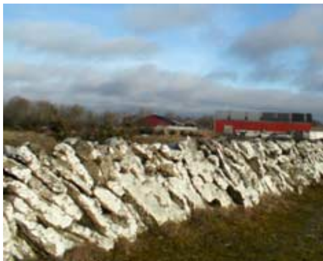
Stupställd stenvmur i Sandby socken.
