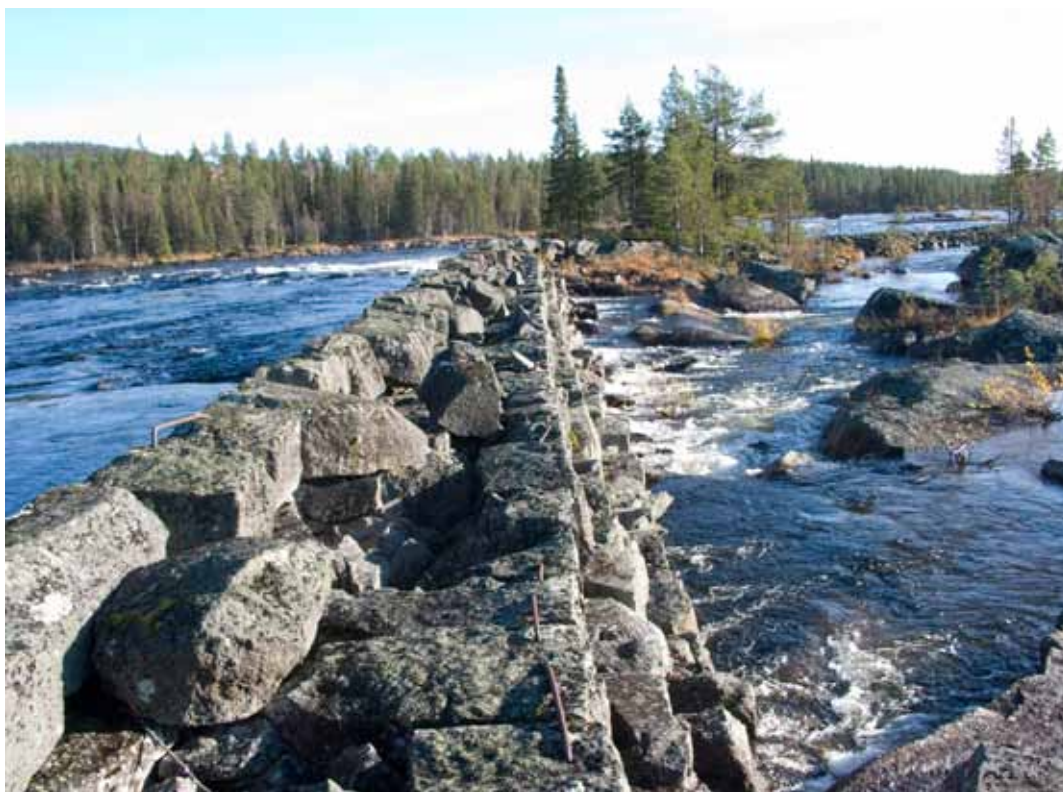
Kilstensmur som uppförts för flottningen i Laisälven, Sorsele kommun, Västerbottens län. Foto: Jeanette Joelsson
