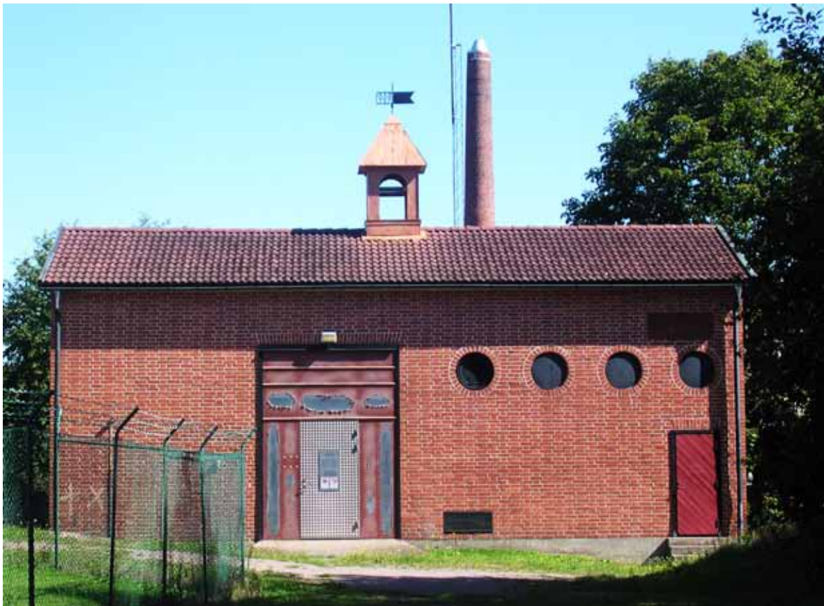
Kraftstationen i Storebro bruk vid Stångån från 1949 är fortfarande i bruk, Kalmar län. Foto: Coco Dederig.
