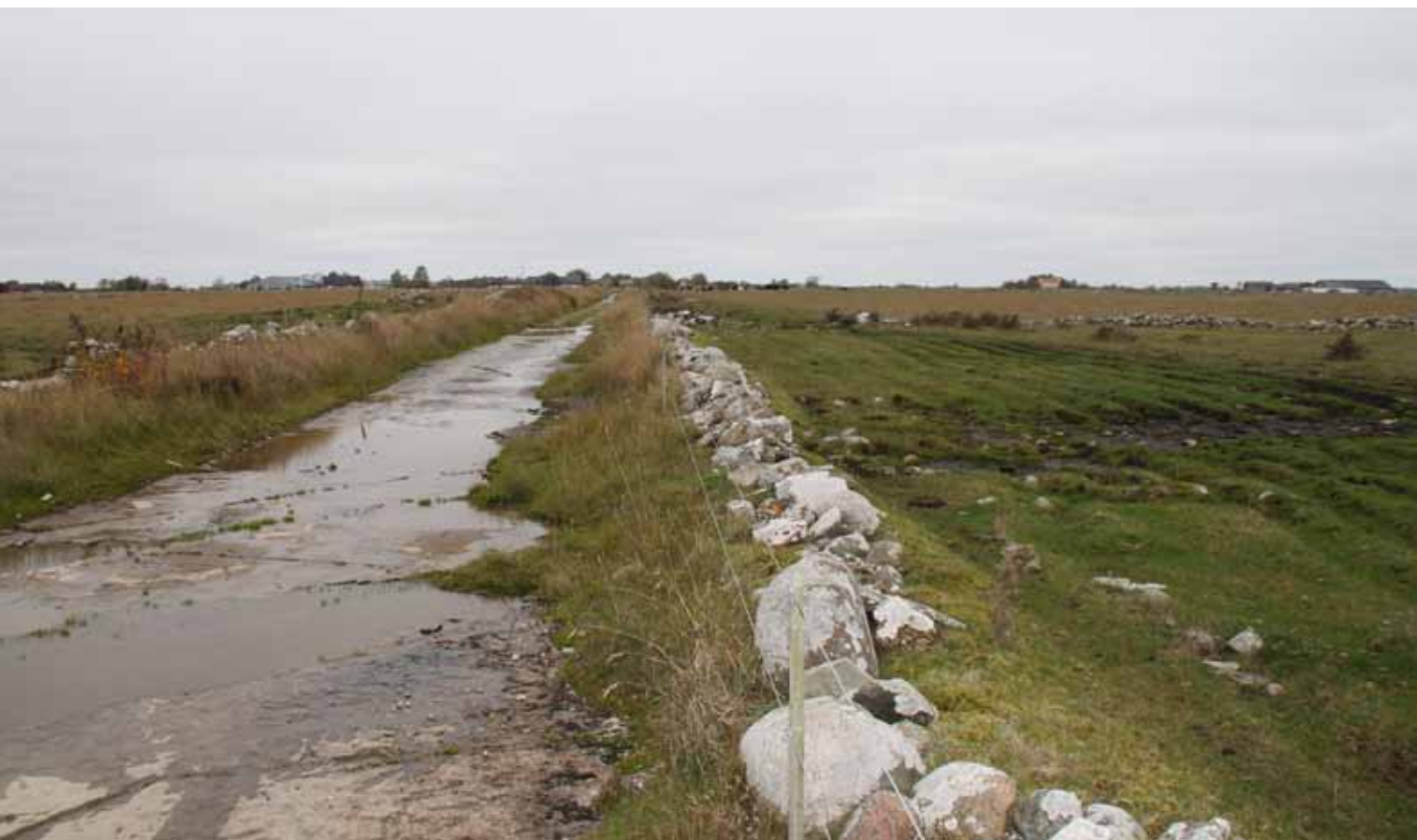
Övra Segerstad. Gärdesmuren från öster upp mot byn som skymtar i bakgrunden. I sjögatan som går längs gärdesmuren har jorden tagits bort och flisan ligger bar. Gärdet till höger i bild.
