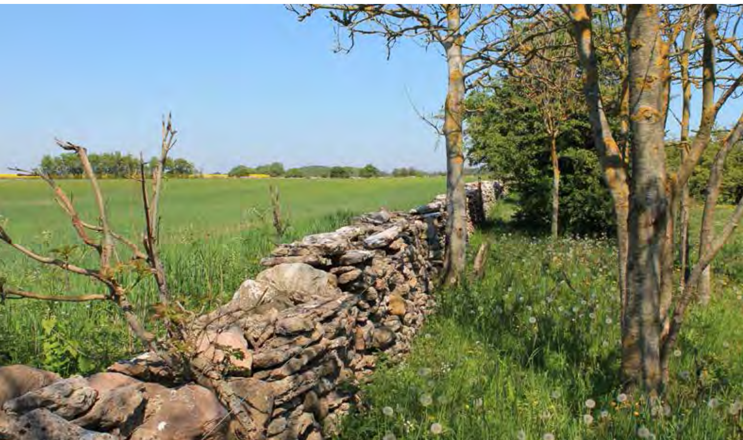
Sörby gårde. Gärdesmur i den sydöstra delen av gården.
