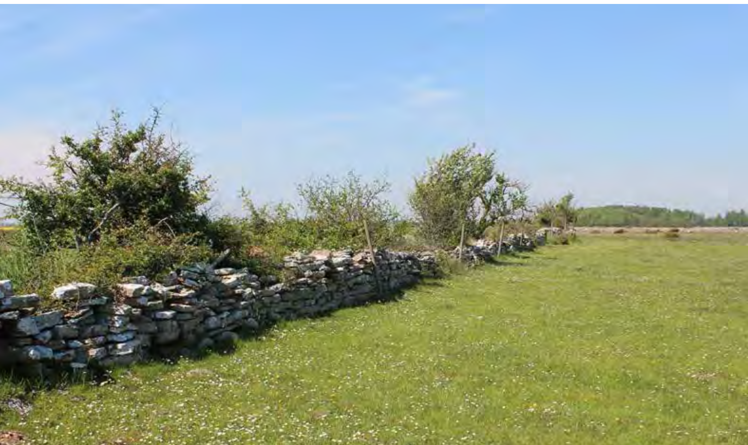
Olstorp. Gärdesmuren i östra kanten mot Stora alvaret. Gärdet ligger bakom träd- och buskridån.
