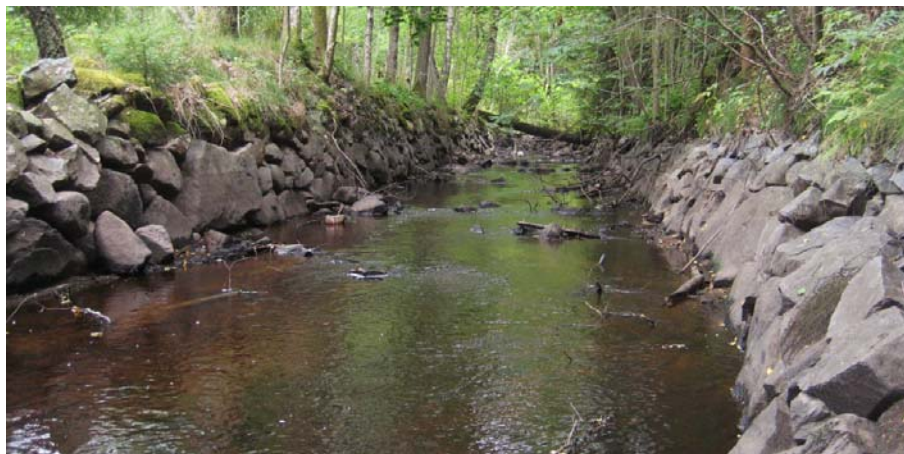
Fig 7. En av färrorna vid Tjurkö kvarn. Fåran är kraftigt rensad och omgjord till en utloppskanal.
