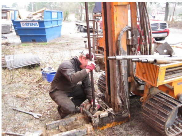
Figur 6 Installation av GV-rör (stål)
