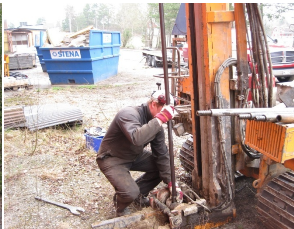
Figur 3 Skruvborrning samt installation av gv-rör (stål, 1 tum)
