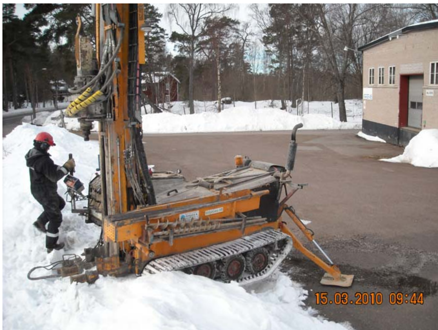
Borrning och installation av grundvattenrör vid Ry1. Mycket snö och kallt.
